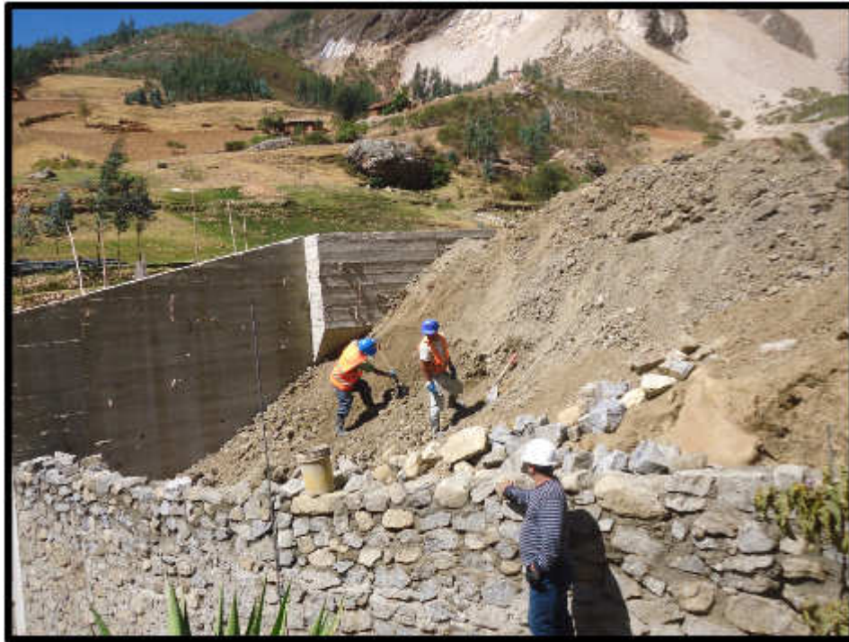
Trabajadores realizando sus actividades; la empresa aun no utiliza la maquinaria pesada.
