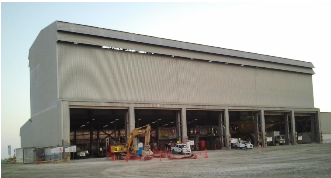
Figura: 15. Espacio Físico del Taller de Mecánica.
