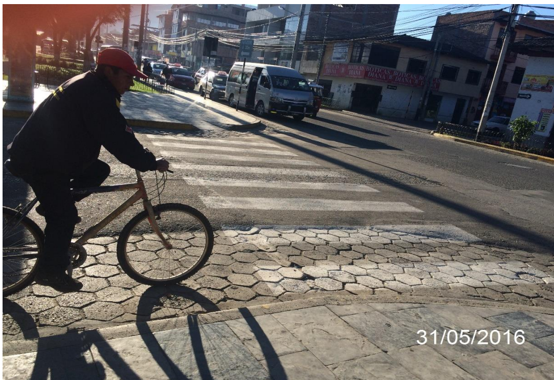
Fotografía 16 - cruce conectado solo con una rampa por un extremo
