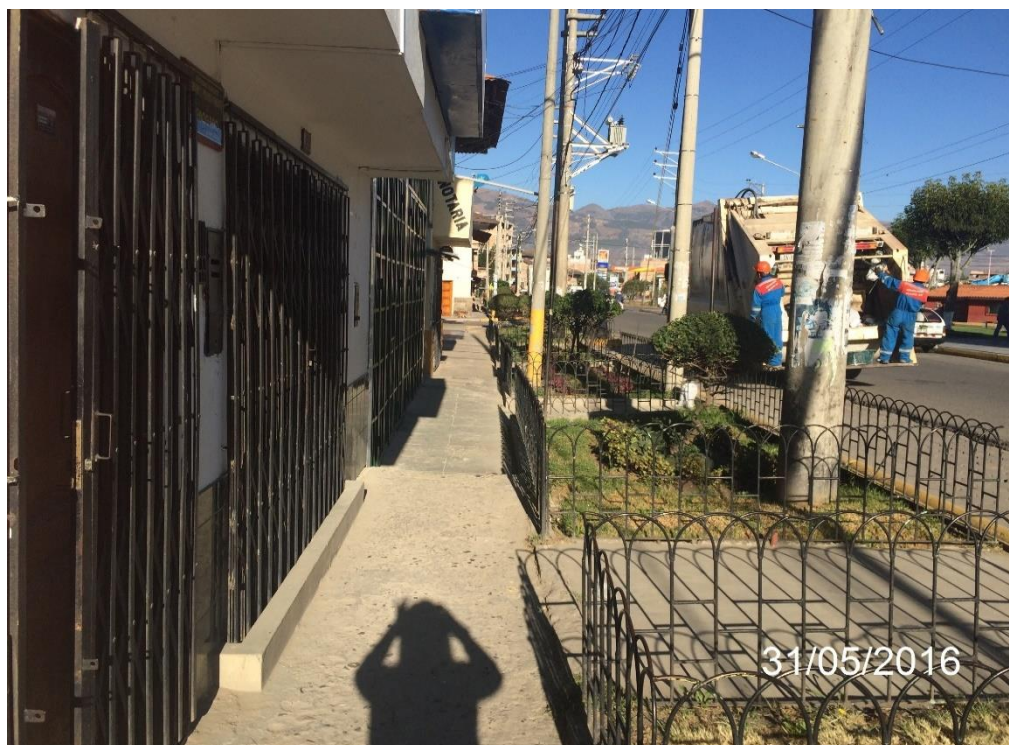
Fotografía 14 - Acera A-10 con distintas alturas que no presenta rampas
