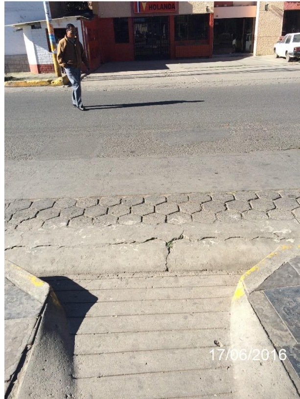
Fotografía 14 - Acera A-10 con distintas alturas que no presenta rampas
