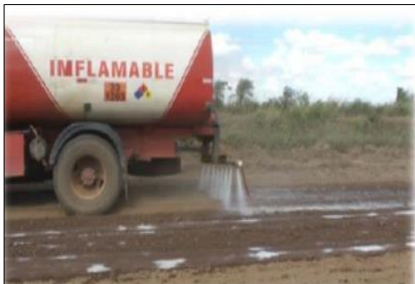
Figura N° 05: Camión cisterna en proceso de la aplicación del estabilizador maxxseal100.
