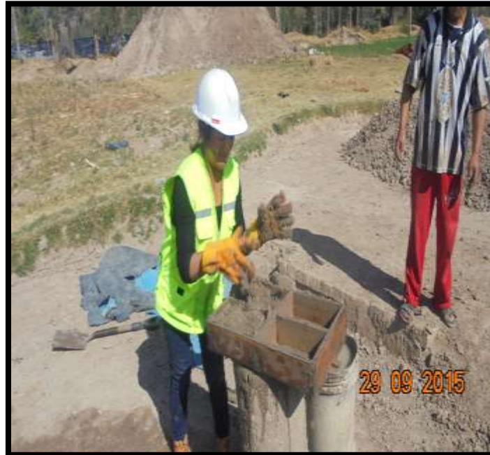
Fotografía N° 15: Moldeado de la mezcla.
