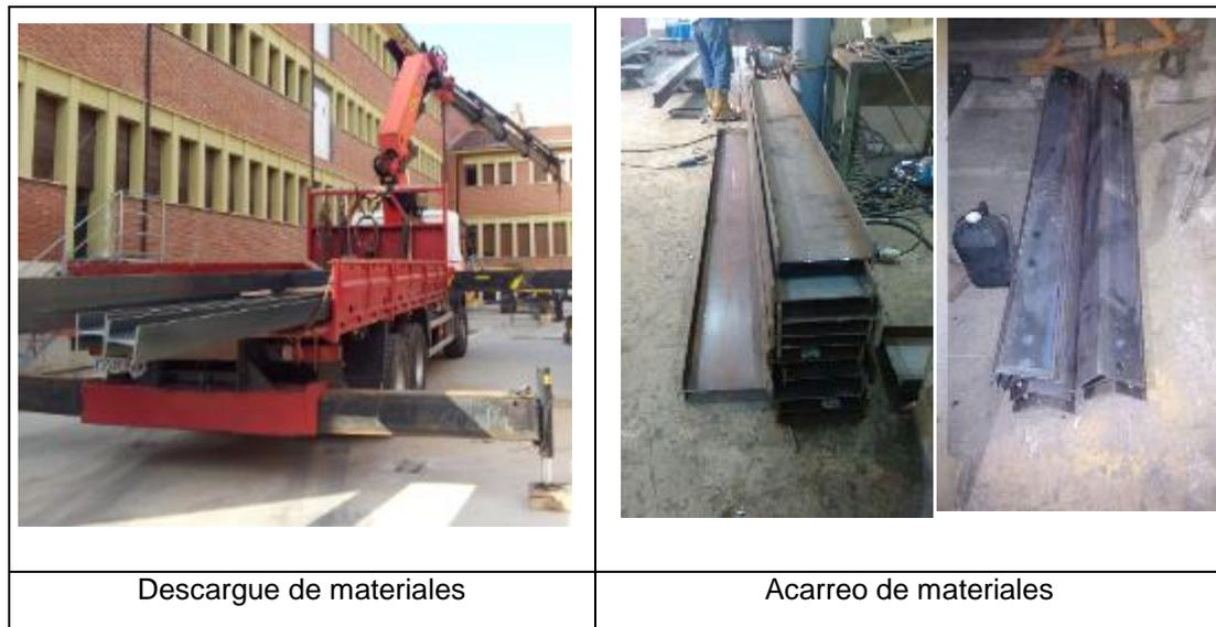
**Figura n.º 3-25. Transporte y recepción de materiales del disipador**
