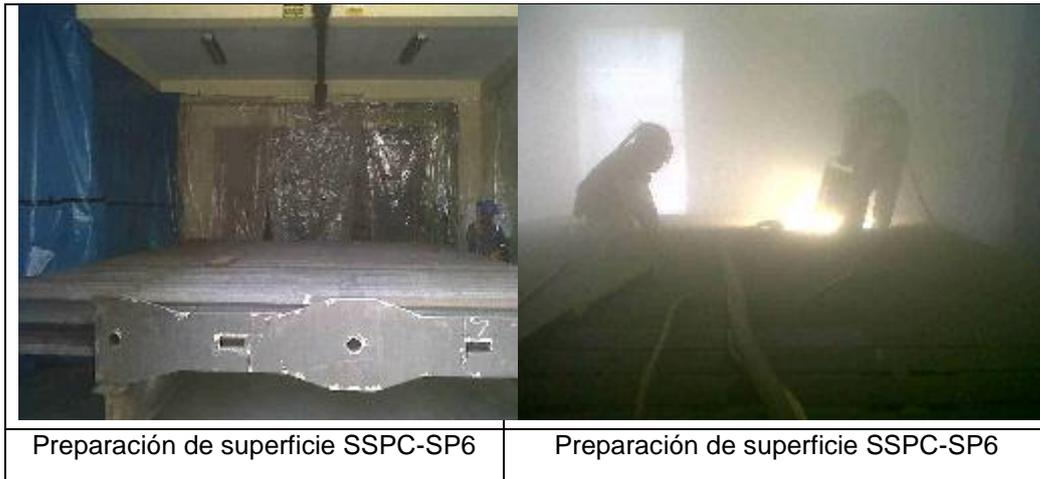
**Figura n.º 3-32. Tratamiento de superficie SSPC –SP 06 de disipador**
