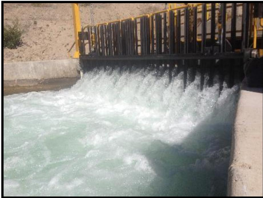
**Figura n.º 3-43. Prueba preliminar de inmersión de dissipador**
