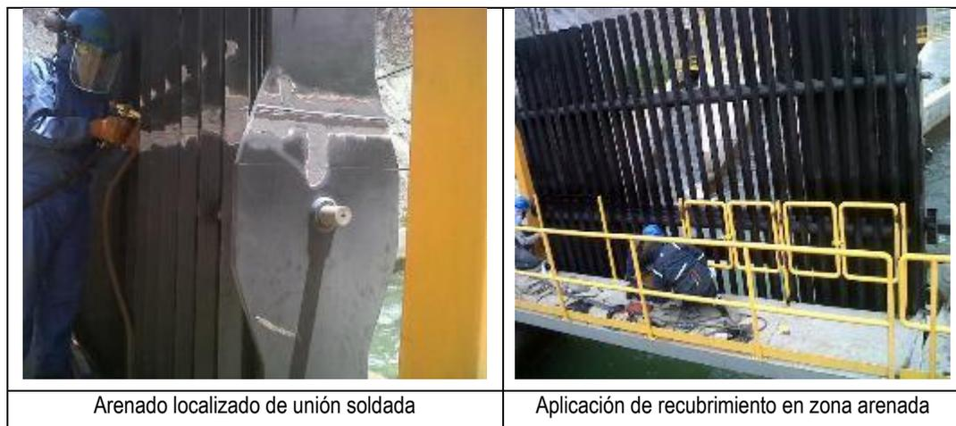
**Figura n.º 3-41. Resane de zona dañada y tratamiento de superficie**
