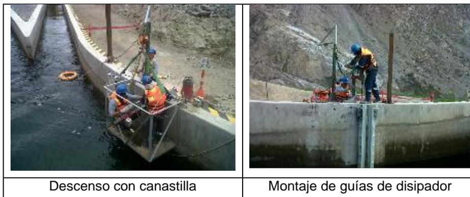
**Figura n.º 3-36. Esquema de montaje de pórticos y montaje de guías de disipador.**
