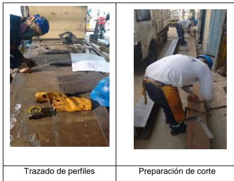
**Figura n.º 3-26. Trazado y preparación de perfiles**
