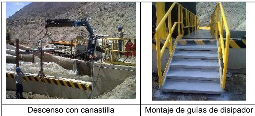
**Figura n.º 3-37. Montaje de pasarela in situ con grúa de 15tn**
