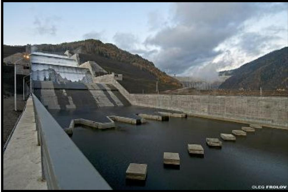
**Figura n.º 2-9. Disipadores de energía hidráulica**
