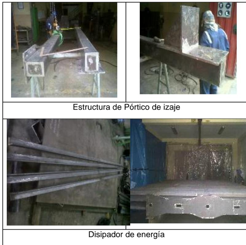
**Figura n.º 3-28. Armado de piezas de disipador, pasarelas y pórtico**
