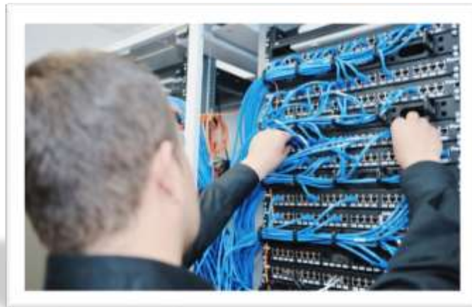
Figura 7. Cableado Estructurado con Fibra Óptica
