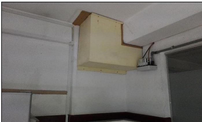
*Figura n.º 4.7.* Recubrimiento de tubería y cables.
