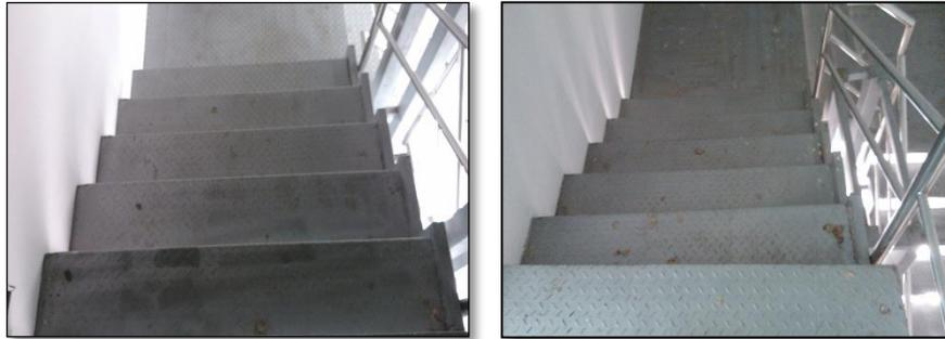
*Figura n.º 3.31.* Escalera de evacuación sin señalización ni cinta de seguridad para escalones.
