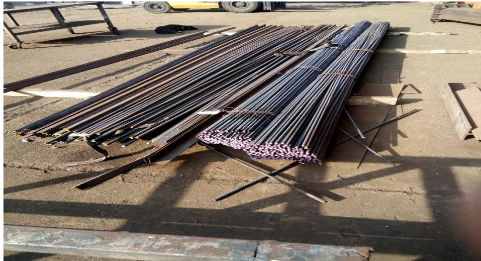
Figura N°09: Barras lisas y ángulos mal ubicados
