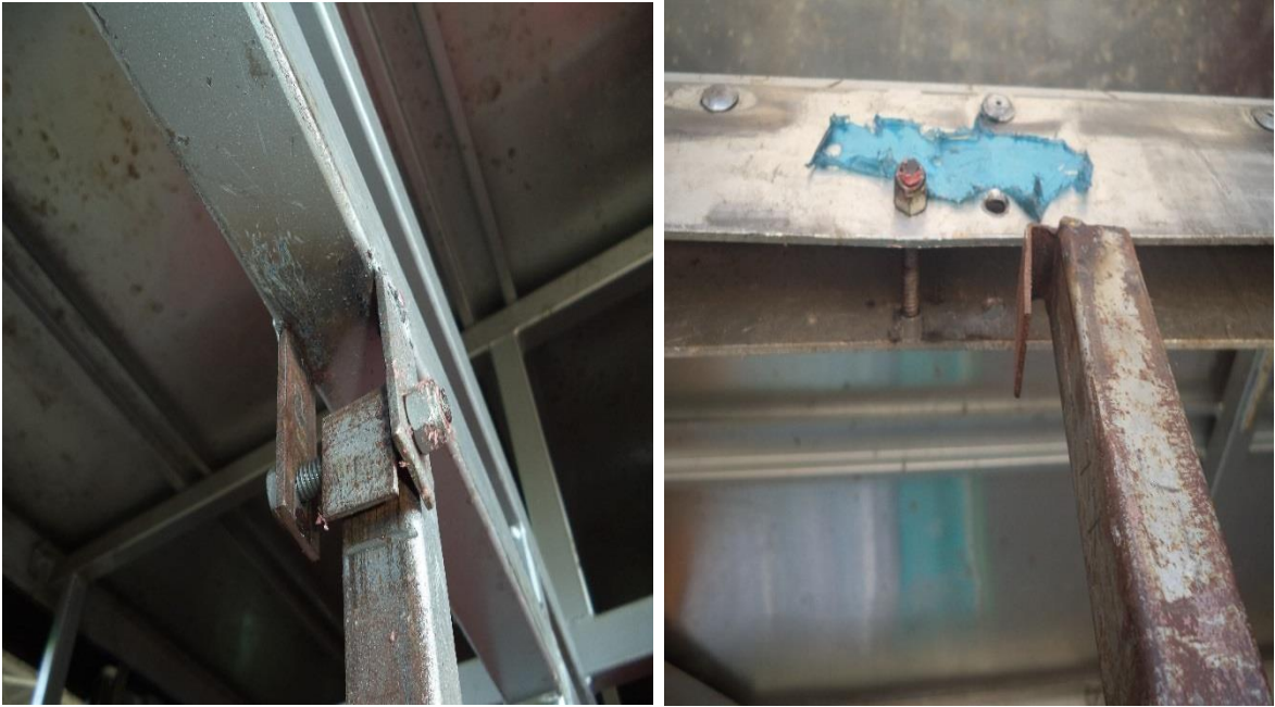
Figura 11 : Instalación de soportes articulados superiores.
