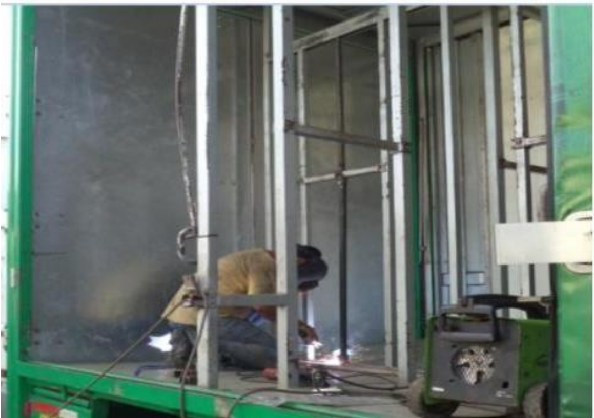
Figura 12 : Instalación de soportes articulados inferiores.
