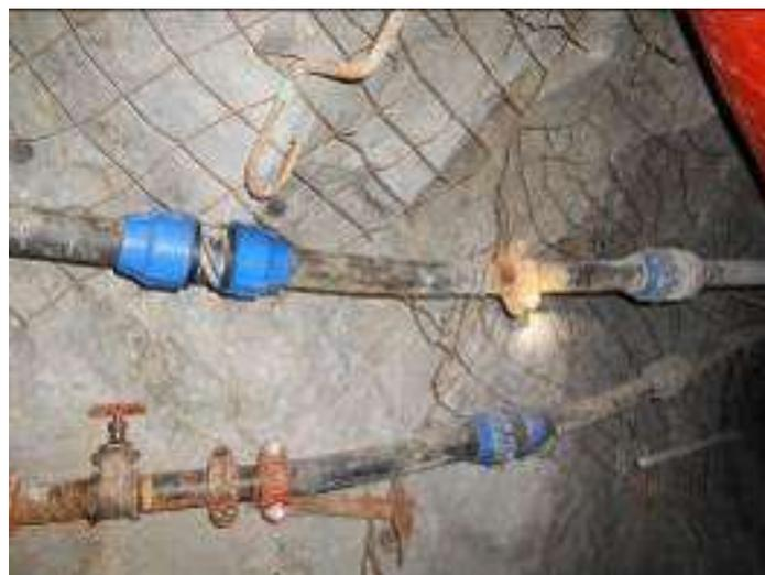
*Figura N° 37. Tuberías de servicio de aire y agua*
