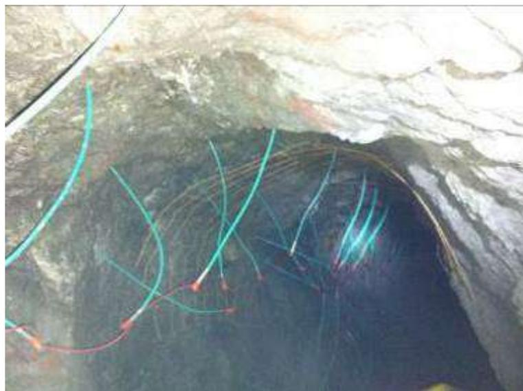
*Figura N° 14. Guías Rápidas de Voladura*
