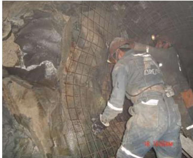
*Figura N° 15. Sostenimiento con Mallas*
