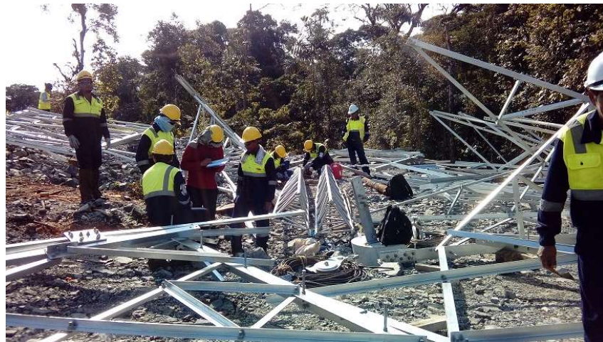
Figura 7. Partida Crítica Pre-ensamblaje de torres.
