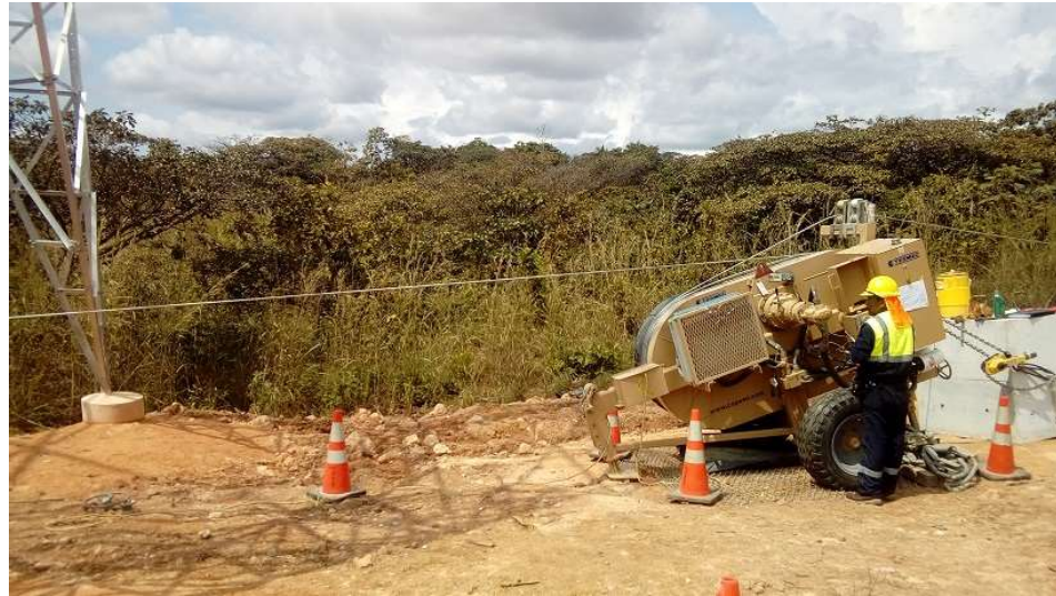
Figura 11. Partida Crítica Tendido de conductor
