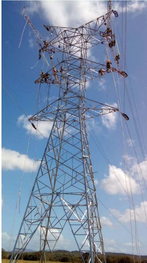
Figura 12. Partida Crítica Nivelado y grapado de conductor
