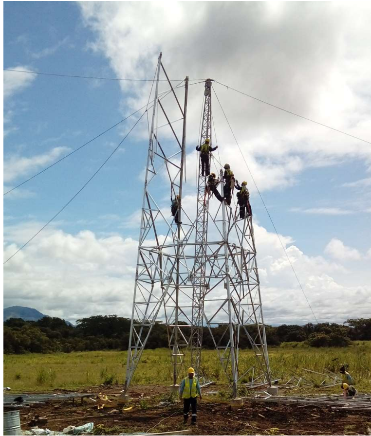
Figura 8. Partida Crítica Montaje de Torres
