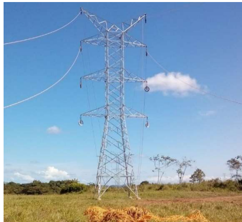
Figura 10. Partida Crítica Instalación de cordina.
