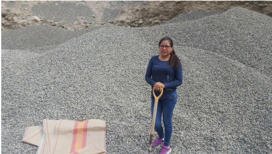
Figura 29: Extracción de los agregados de la cantera.
