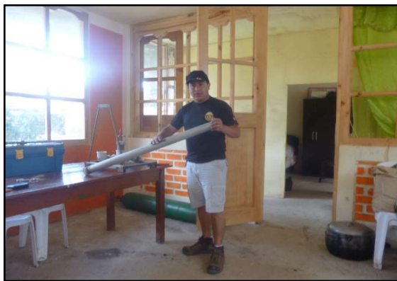
Figura 47. Lijando las diferentes tuberías galvanizadas que serán pintadas para evitar la corrosión de las mismas.
