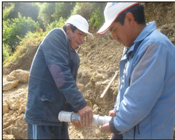
Figura 57. Embonado de componentes de la bomba de ariete hidráulico.
