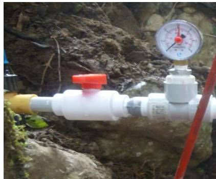
Figura 34. Elementos que conformaron el montaje de la bomba de ariete hidráulico.
