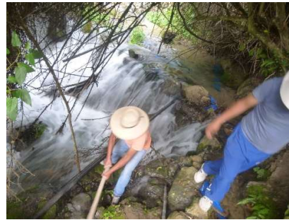
Figura 31. Elementos que conformaron el montaje de la bomba de ariete hidráulico.
