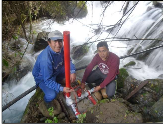
Figura 64. Montaje de la bomba de ariete hidráulico.
