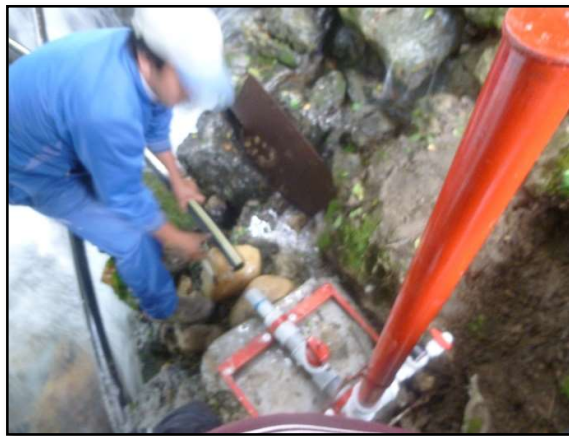
Figura 65. Acoplamiento de la tubería de suministro.
