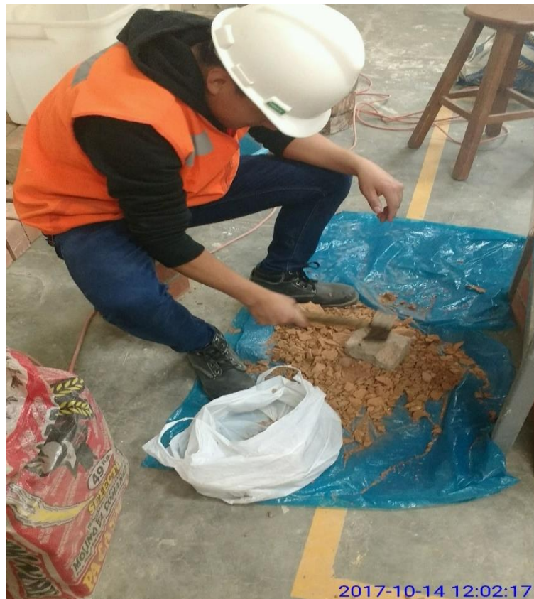
Figura 26: Trituración de los desperdicios de ladrillos.
