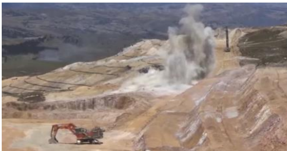
Figura 25. Proceso de voladura del banco QM-4040. (Minera Yanacocha SRL, 2017)
