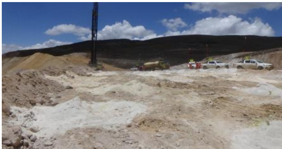
Figura 24. Proceso de pre-voladura del banco QM-4040. (Minera Yanacocha SRL, 2017)
