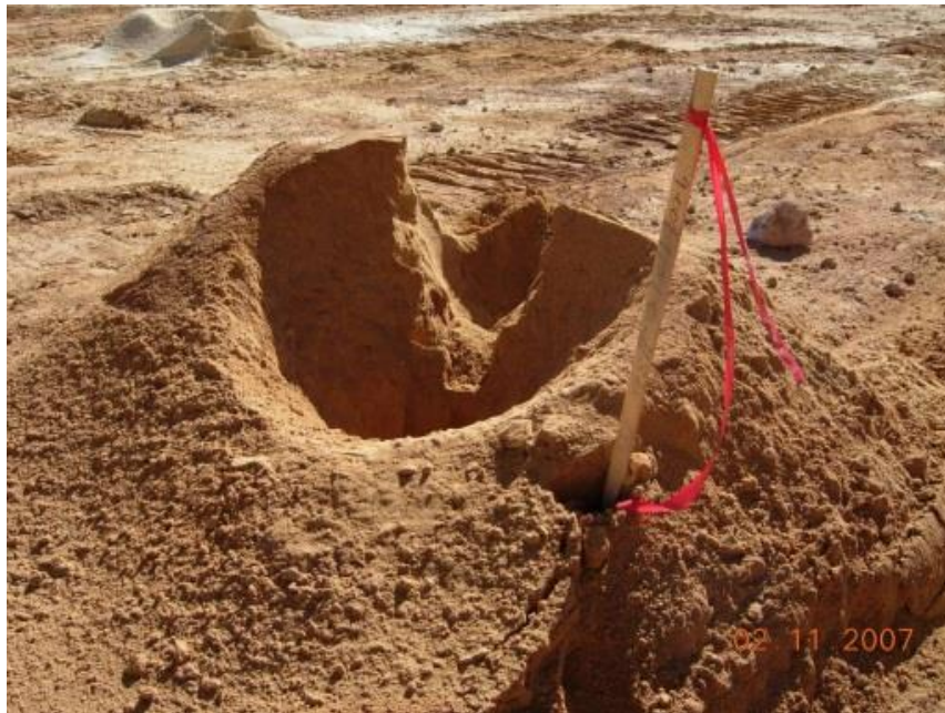
Figura 5. Ubicación e identificación de mallas y taladros. (Jara & Roldán, 2017).
