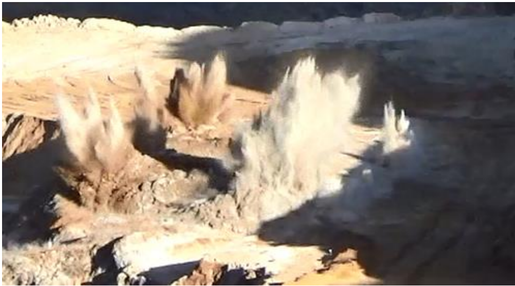
Figura 22. Proceso de voladura del banco QM-4030. (Minera Yanacocha SRL, 2017)
