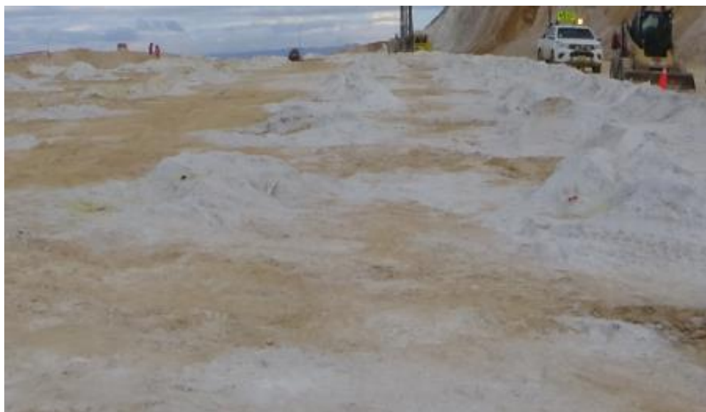
Figura 21. Proceso de pre-voladura del banco QM-4030. (Minera Yanacocha SRL, 2017)
