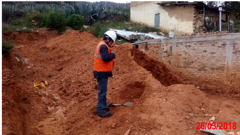
Figura 10 Obtención del suelo para los adobes.
