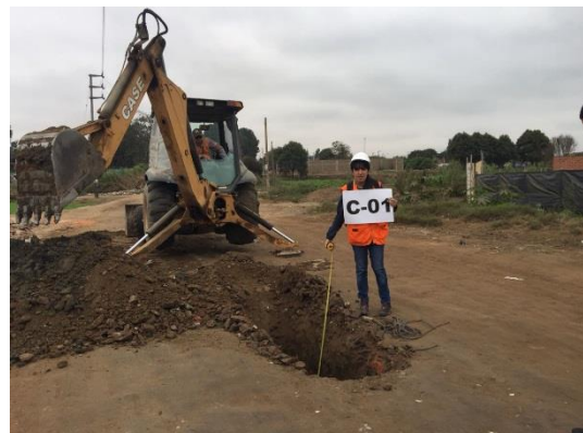
Fotografía N° 04: OBTENCIÓN DE MUESTRA DE SUELO A TRAVÉS DE LA ELABORACIÓN DE CALICATA.
