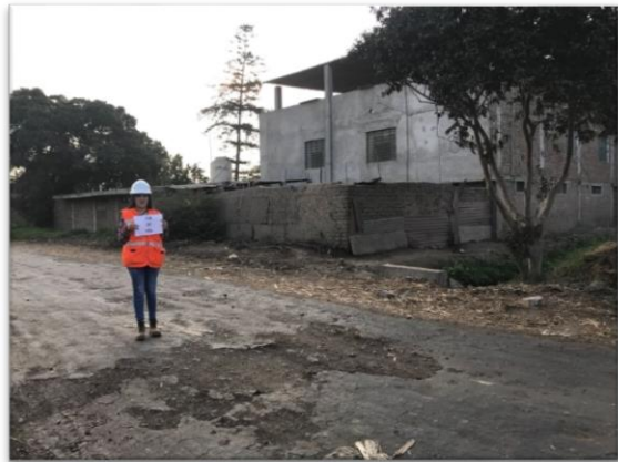
Fotografía N° 02: RECONOCIMIENTO DE FIN DE VÍA A TRABAJAR
