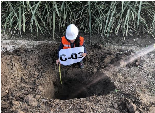
Fotografía N° 03: OBTENCIÓN DE MUESTRA DE SUELO A TRAVÉS DE LA ELABORACIÓN DE CALICATA.
