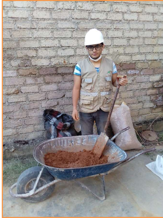
Fotografía 32: Preparación de material para elaboración de adobes.
