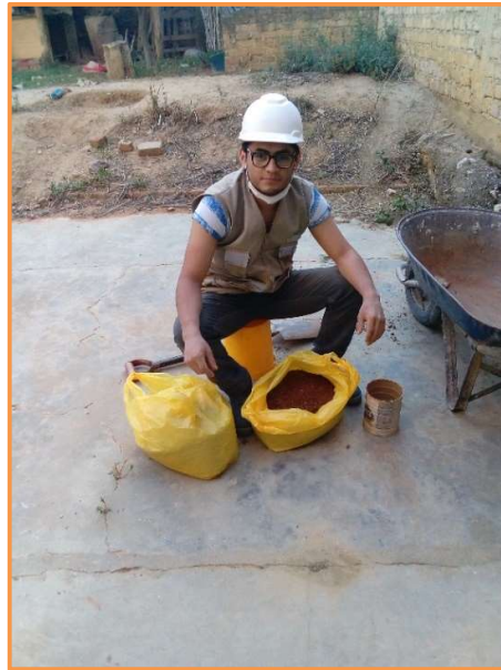
Fotografía 33: Preparación de material para elaboración de adobes.
