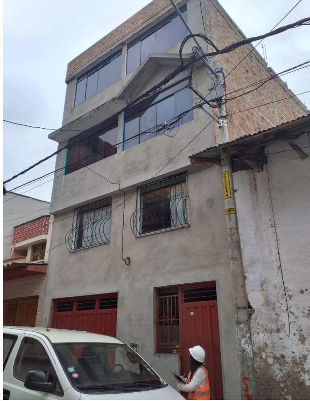
Toma de datos en campo, visualizando cables parcialmente expuestos y los retiros
