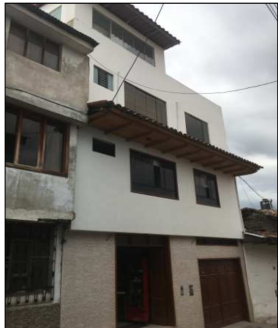
Toma de datos en campo. Se las tuberías que vierten agua de lluvia en la vía pública
