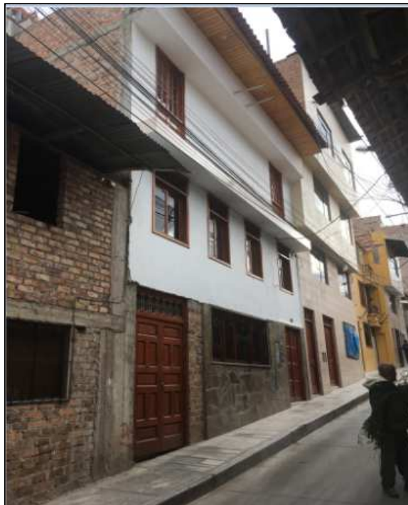
Imagen de la casa ubicada en Jr. Unión cdra. 2
