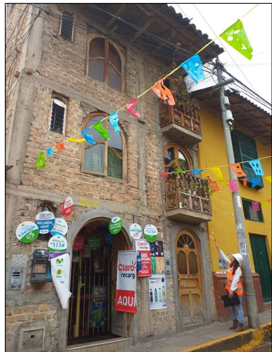
Toma de datos en campo. Se observan balcones
