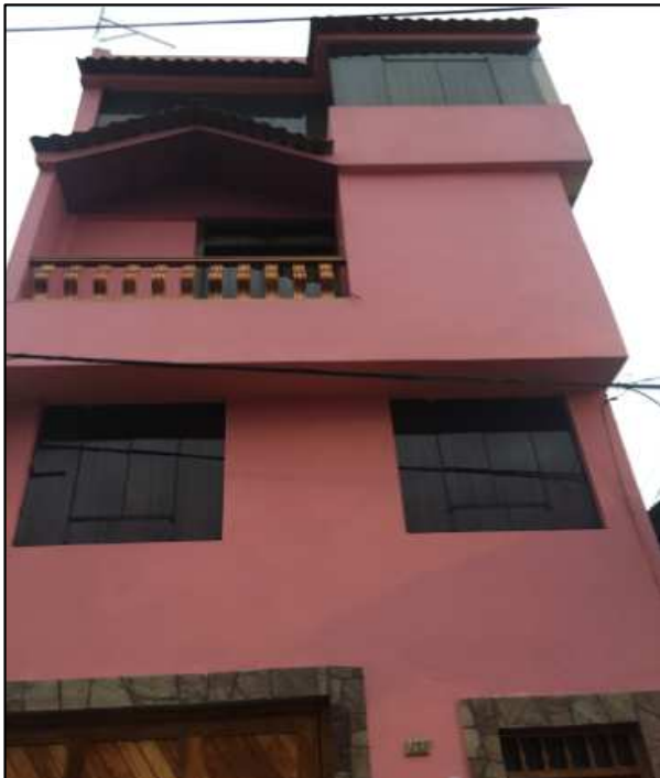
Imagen de la casa ubicada en Jr. La Esperanza cdra. 1
