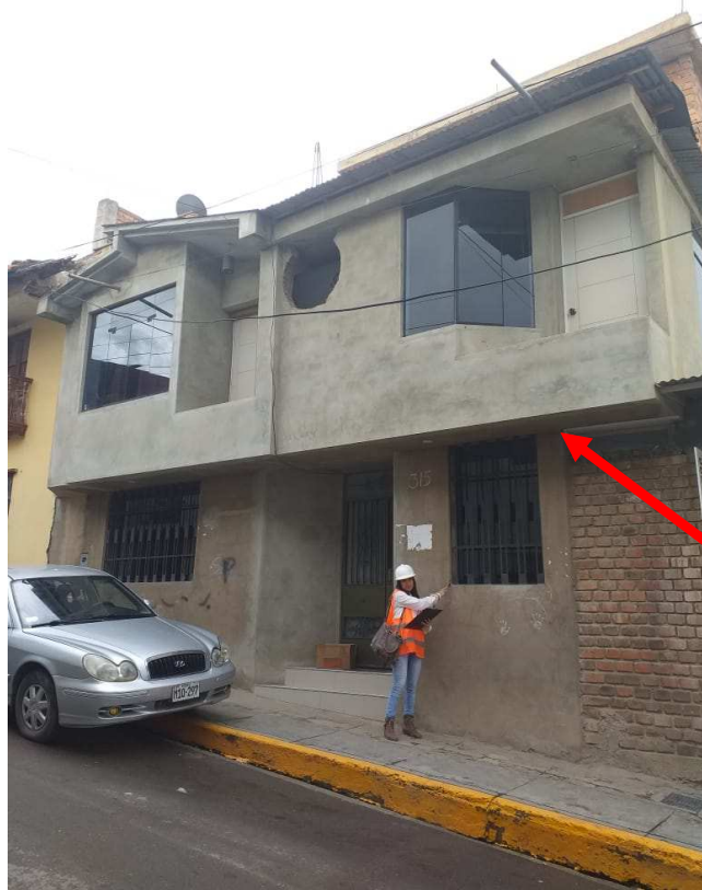
Toma de datos en campo. Se observan los voladizos.
