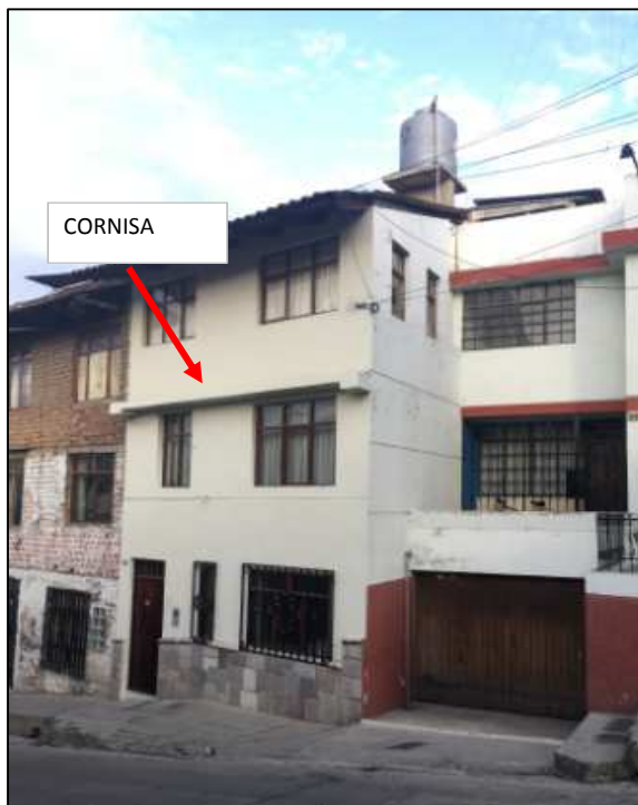
Imagen de la casa ubicada en Jr. Cruz de Piedra cdra. 4
