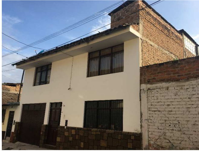
Imagen 7: Edificación En buen estado
