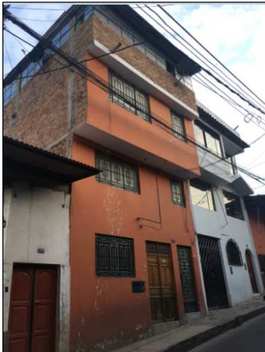
Imagen de la casa ubicada en Jr. G. Urrelo cdra 3
