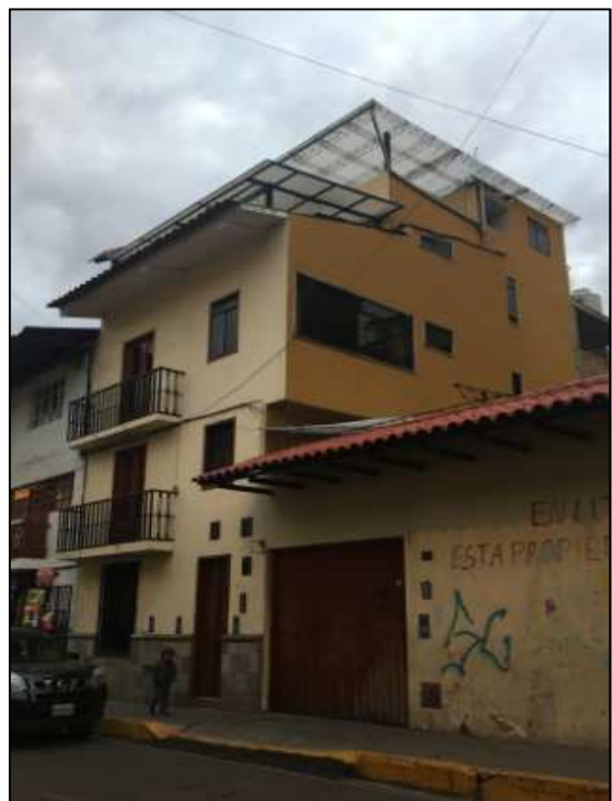
Imagen de la casa ubicada en Jr. Amazonas cdra. 10
