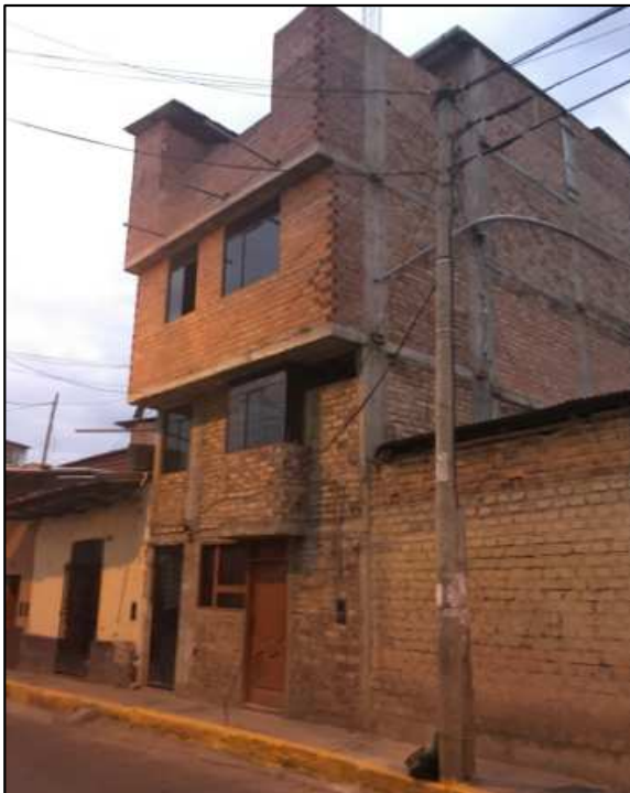
Imagen lateral de la casa ubicada en Jr. Ayacucho cdra. 7
