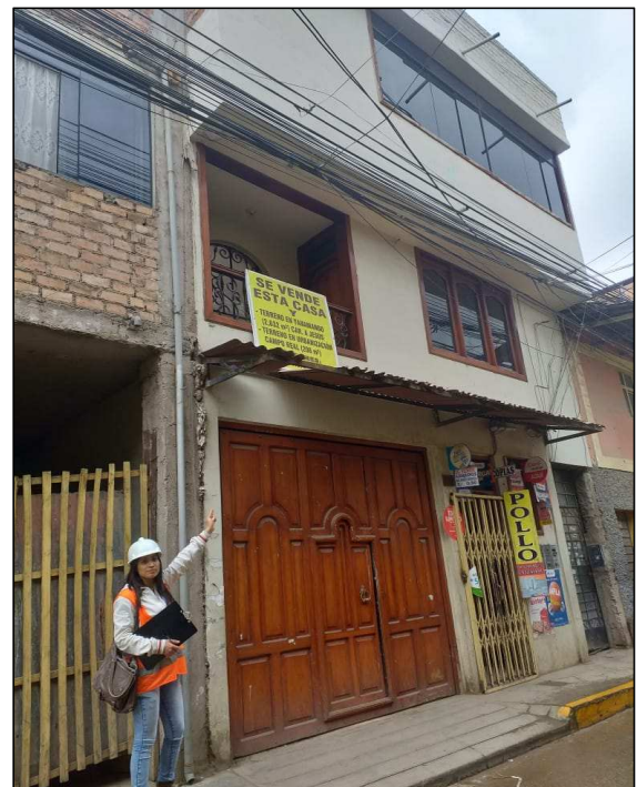
Toma de datos en campo. Se las tuberías que vierten agua de lluvia en la vía pública
