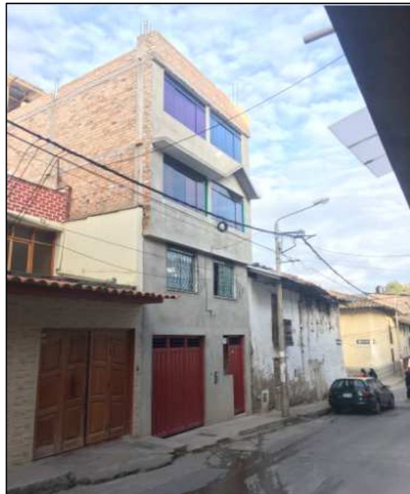
Imagen de lateral de la casa ubicada en Jr. Ancón cdra. 3
