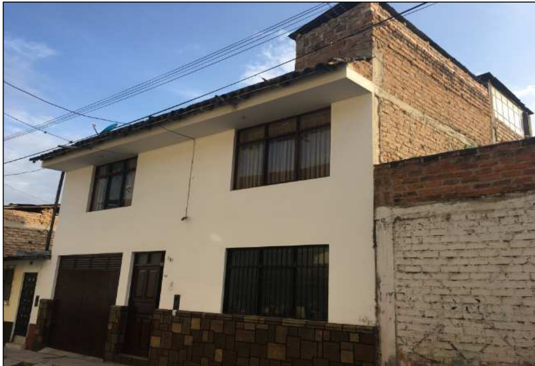
Imagen de la casa ubicada en Jr. Ancón cdra. 2
