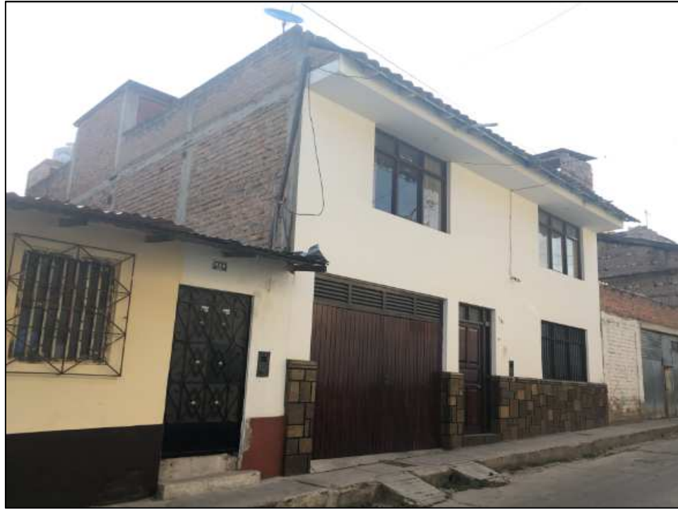
Imagen de la casa ubicada en Jr. Ancón cdra. 2
