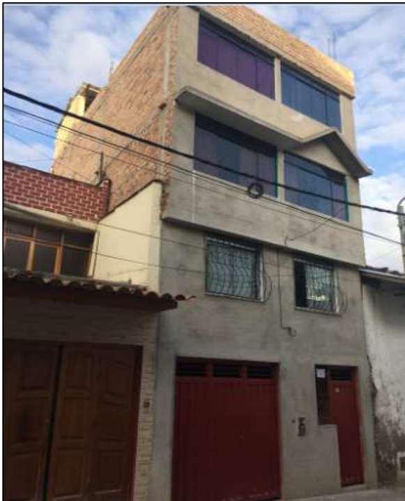
Imagen de la casa ubicada en Jr. Ancón cdra. 3
