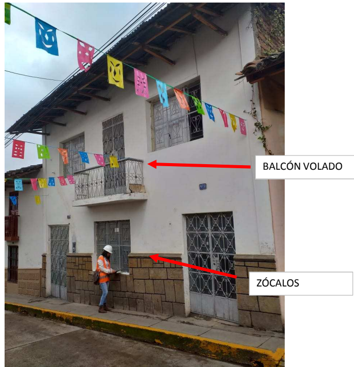
Toma de datos en campo. Se observan balcones y retiros.
