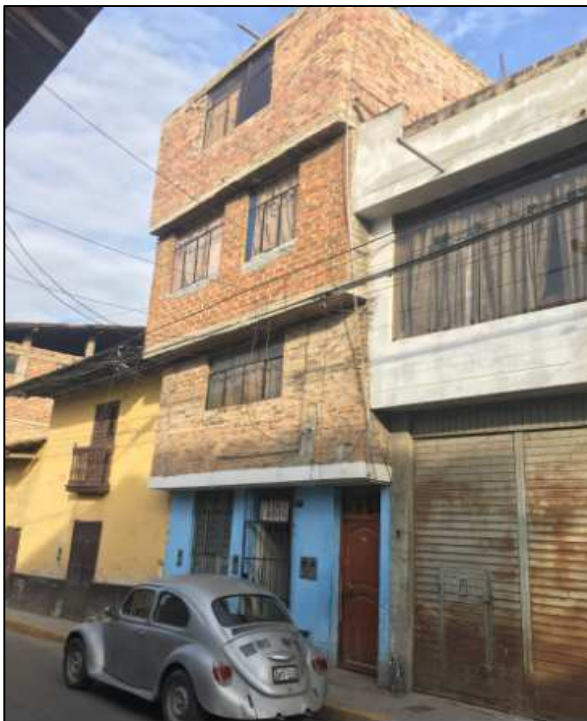
Imagen lateral de la casa ubicada en Jr. Ayacucho cdra. 7
