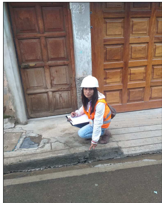
Toma de datos en campo. Se las tuberías de drenaje de agua de lluvia
