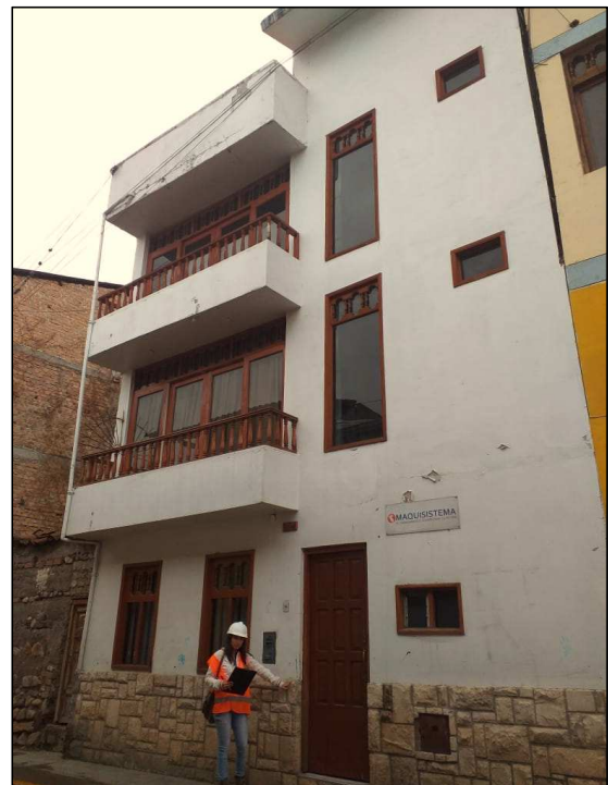
Toma de datos en campo. Se observan balcones y retiros.
