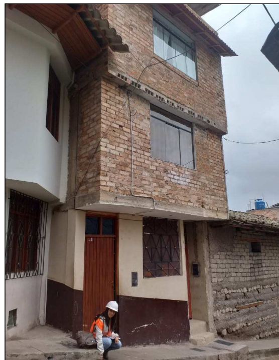
Toma de datos en campo, se visualiza el drenaje de agua de lluvia
