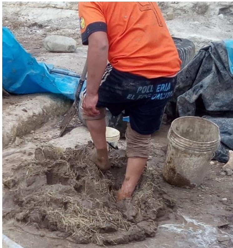
Figura N° 14. Batido del crudo para su homogenización con el Ichu.
