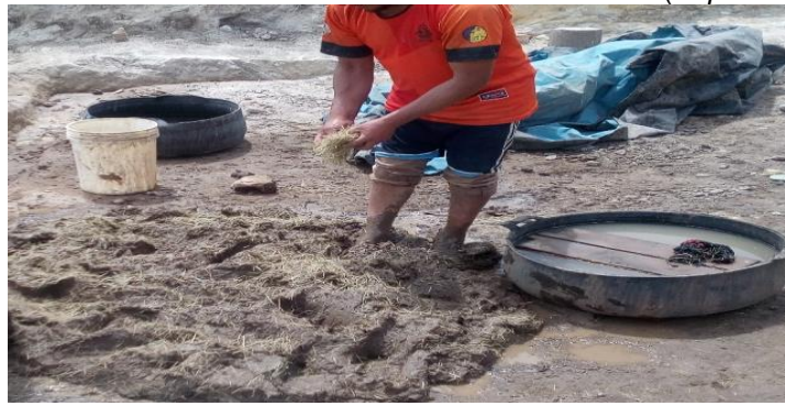
Figura N° 32. Mesclado de Ichu con el crudo.
