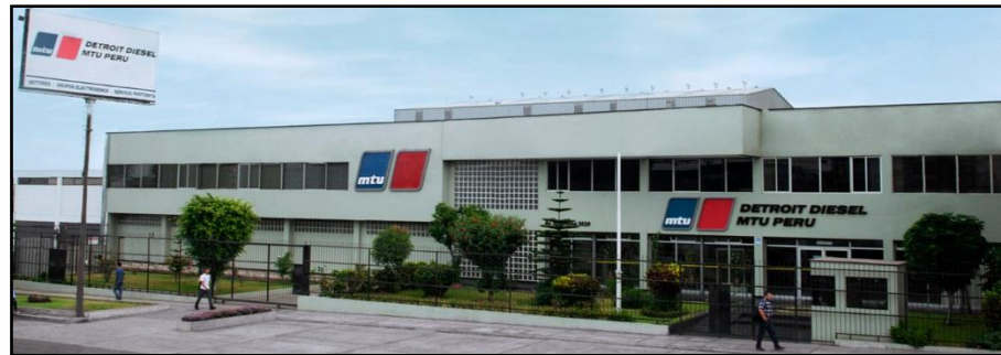
Figura N° 17 Detroit Diesel MTU
