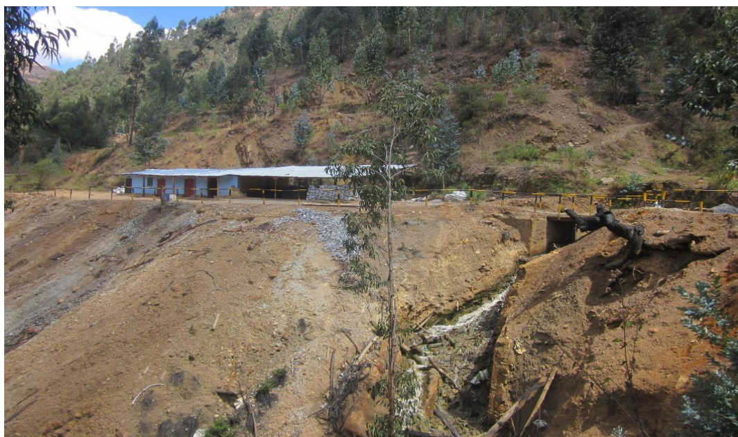
Figura V. Punto N° 03, Nivel V de mina, vertimiento de efluentes. Fotografía tomada 2019.
