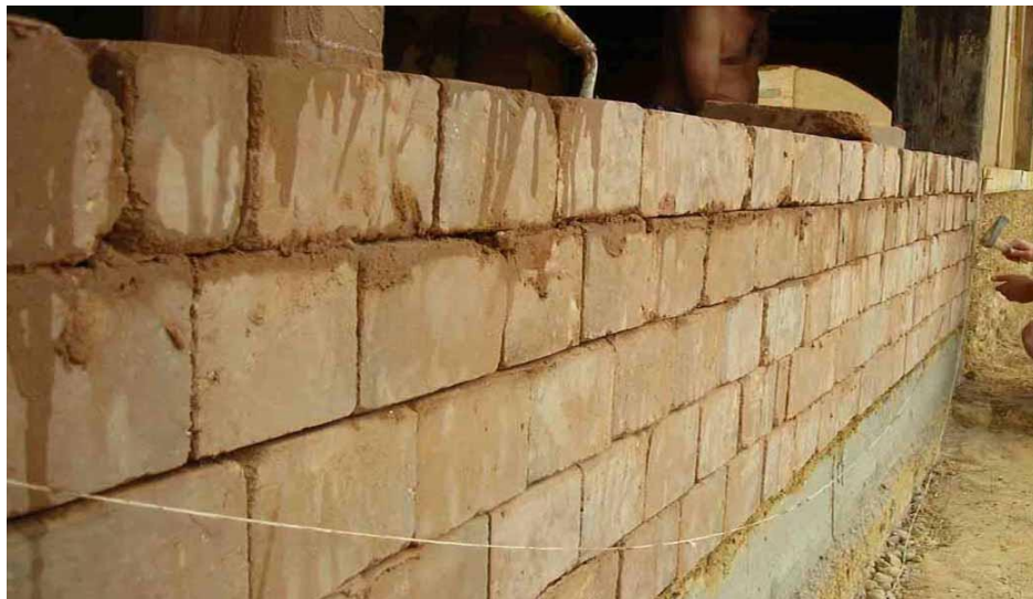
Figura 1. Bloque de tierra estabilizado (Estructuras Bioclimáticas Avanzadas, 2018)
