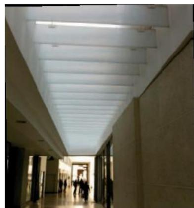
Para este tipo de protecciones se debe realizar un análisis detallado de la trayectoria solar y sus proyecciones para lograr una dimensión adecuada de los elementos que la conforman (Figura 5.58).
