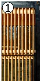
**Protección:** perfiles de madera de 0.07 cm, estos permiten el ingreso parcial de luz natural, y no ocasionar deslumbramientos en el espacio o interior del ambiente.
