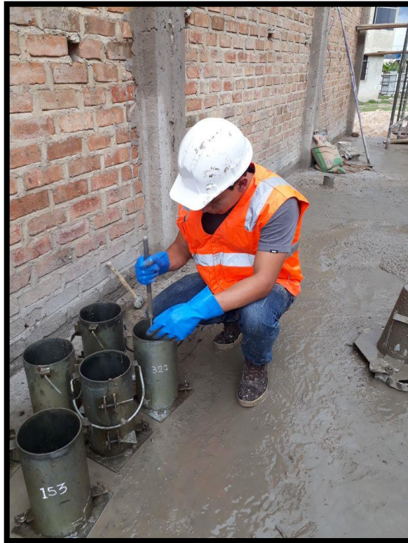
Figura 18 Elaboración de probetas de concreto.
