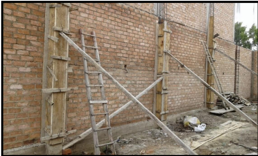
Figura 11 Columnas listas para el vaciado de concreto.
