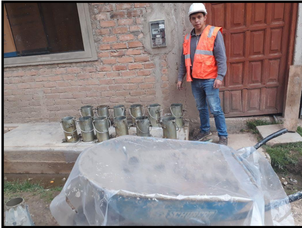
Figura 16 Instalación de moldes en una superficie nivelada.
