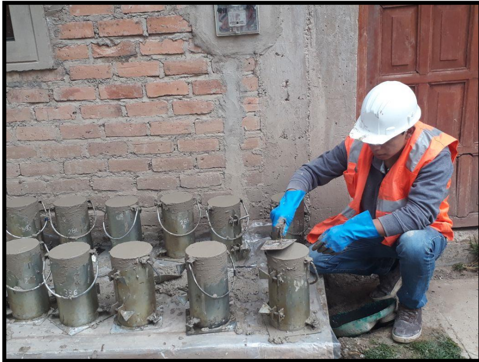
Figura 20 Enrazado de concreto.
