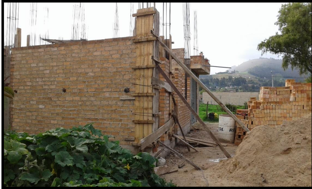
Figura 10 Encofrado de columnas.
