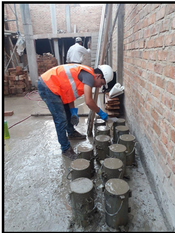
Figura 19 Enrazado de concreto.
