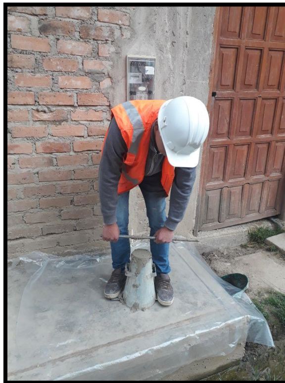
Figura 13 Ensayo de asentamiento del concreto.
