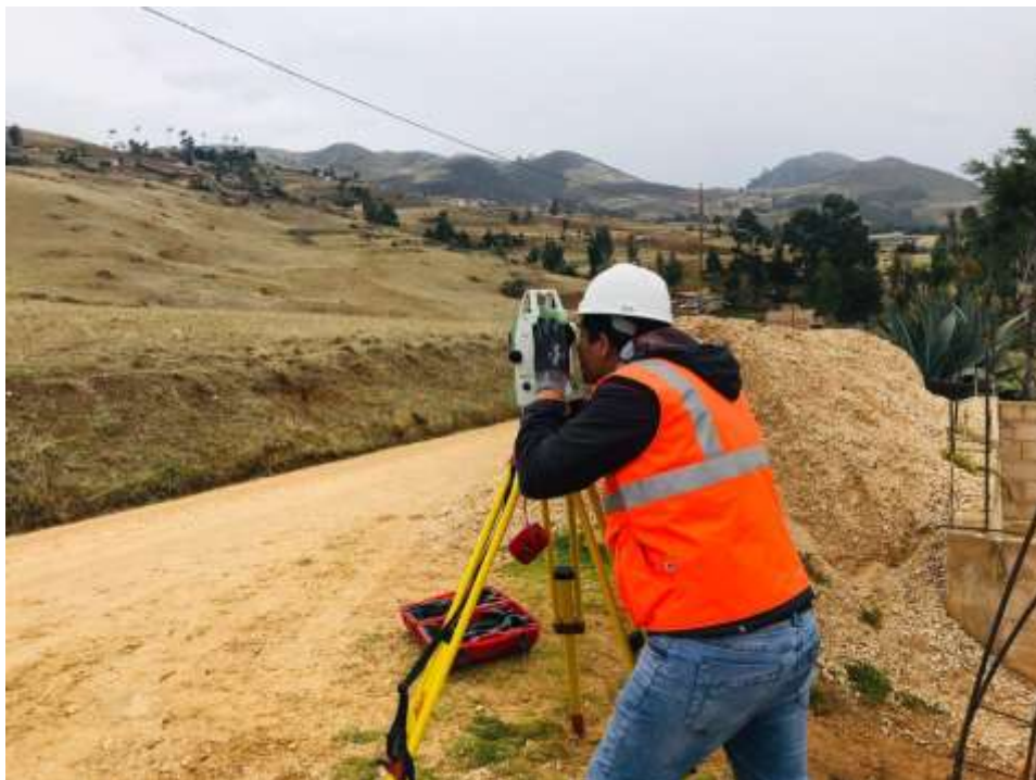
Figura 14 Tomando el primer punto del levantamiento
