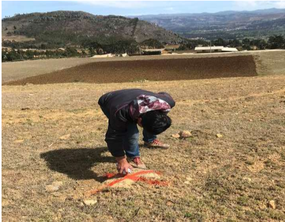
Figura 17 Señalización de los puntos de control
