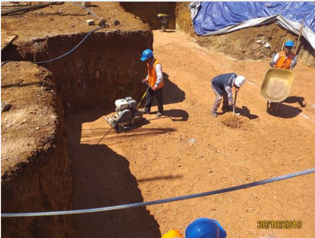
Fotografía 17. Peón no adiestrado ni formado para actividad de compactación haciendo de operario en obra.
