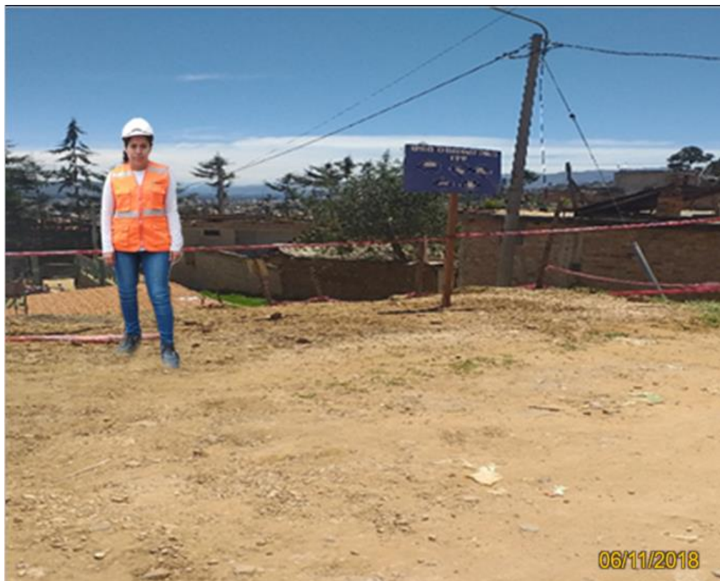
Fotografía 32. Muro perimetral inexistente para dar acceso a la obra.
