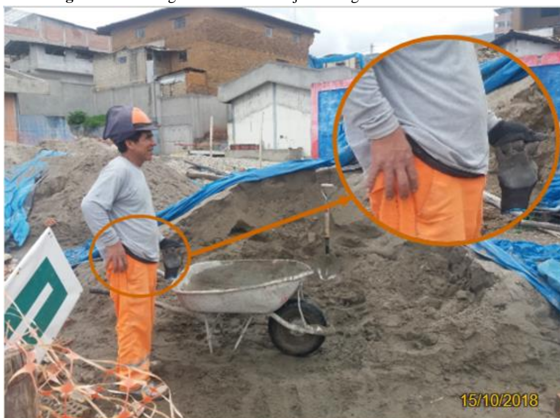
Fotografía 2. Uso de equipo de protección personal para el transporte de materiales.
