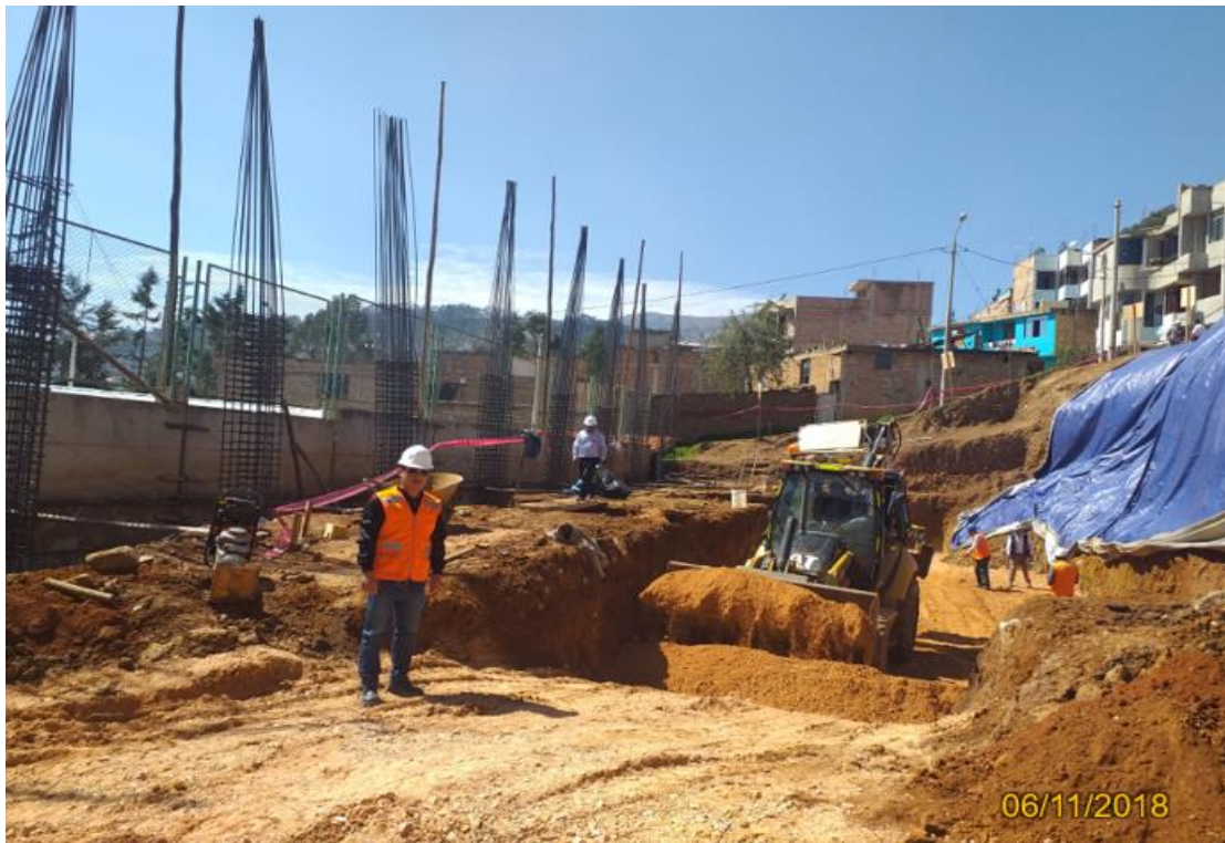
Fotografía 366. El área no está perimetrada, las herramientas no están en su lugar respectivo.
