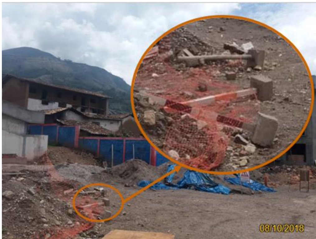
Fotografía 13. Provisión de barreras de señalización de zonas de desmonte sin el mantenimiento vertical adecuado para su fin.
