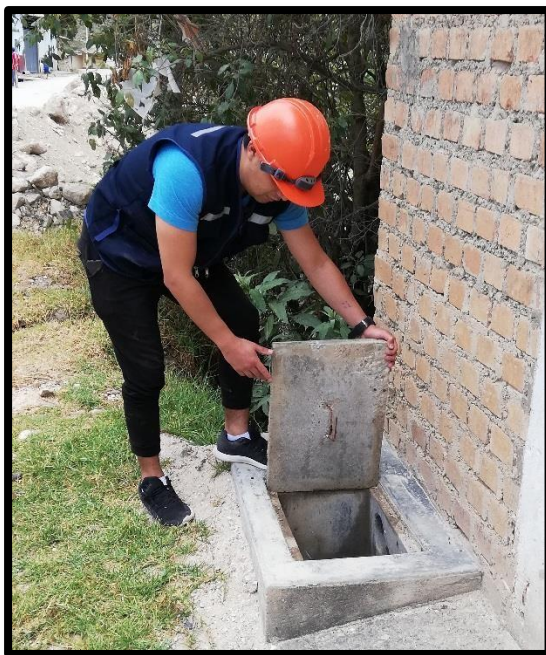
Foto 5: Caja de inspección, Jr. Ricardo Palma
