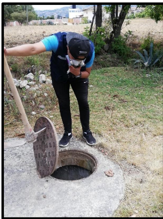
Foto 14: Inspección buzón, Jr. Atahualpa
