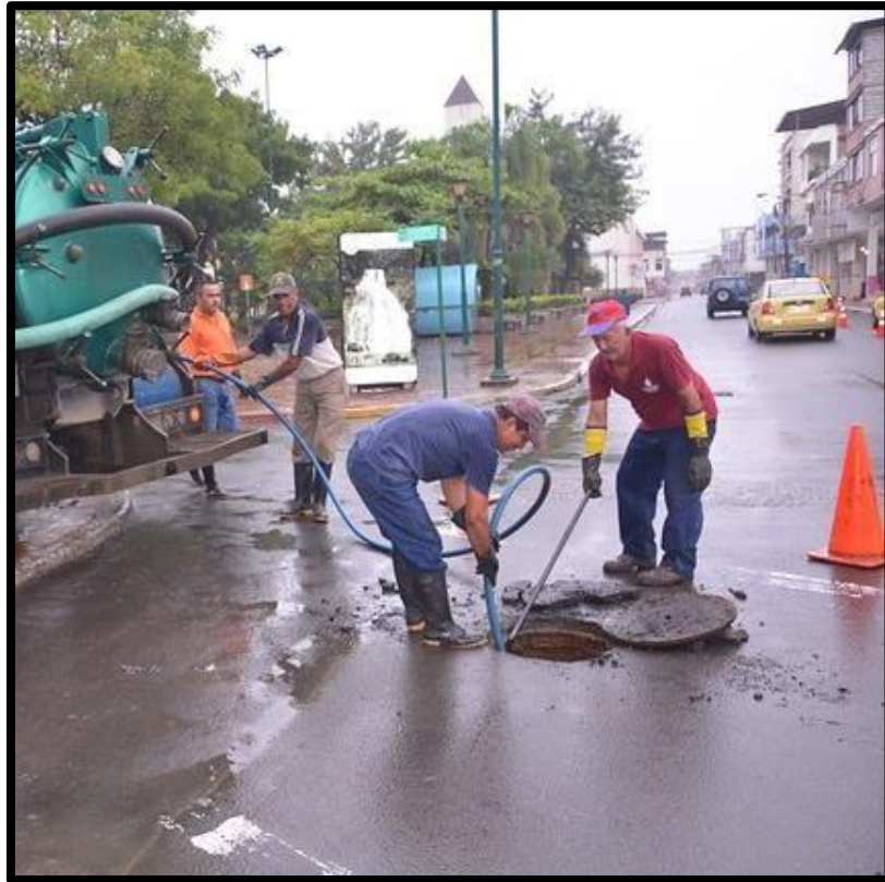
Figura 16. Limpieza de terminales en cabezas de colectores Fuente: Gobierno Autónomo Descentralizado, 2016
