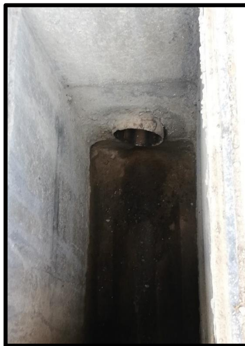
Foto 45: Vista interior caja de inspección, buen estado
