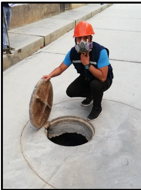
Foto 50: Inspección buzón, Jr. Gonzales Prada
