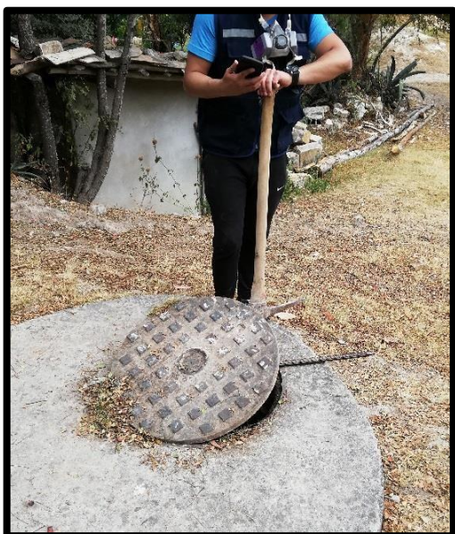
Foto 12: Inspección buzón, Jr. Atahualpa
