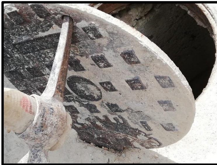
Foto 19: Tapa metálica buzón.
