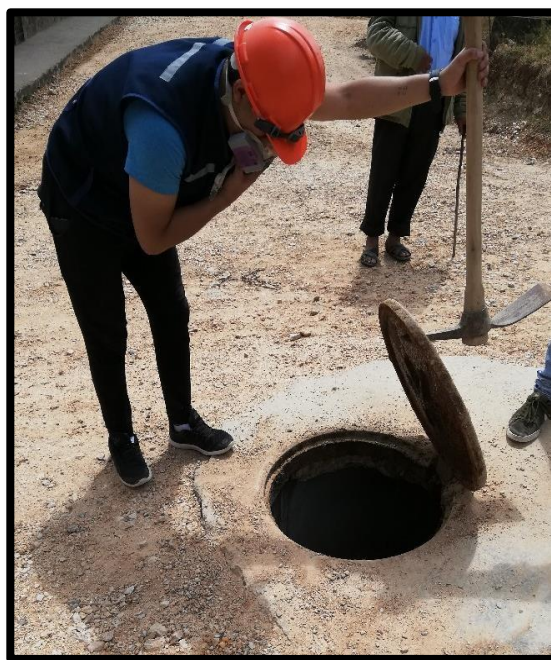
Foto 8: Inspección buzón, Jr. Pról. Atahualpa
