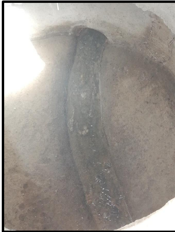
Foto 26: Vista interior buzón, Jr. Raymondi
