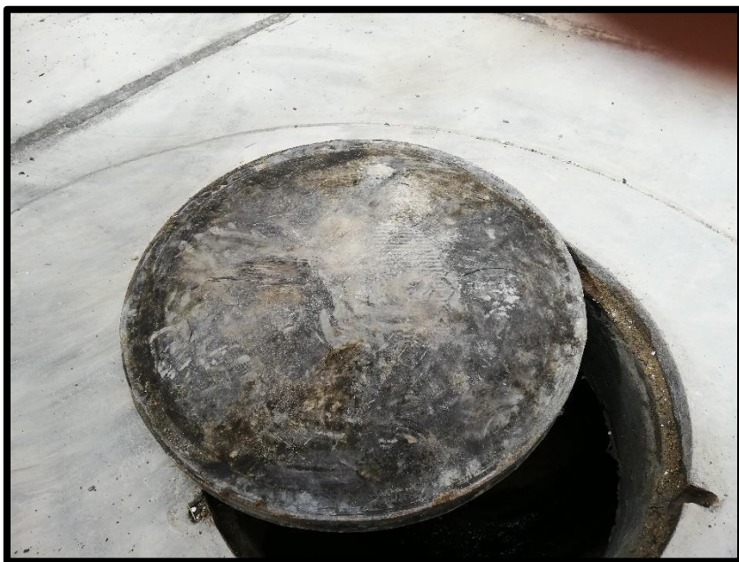
Foto 37: Inspección buzón arranque, Jr. Gonzales Prada
