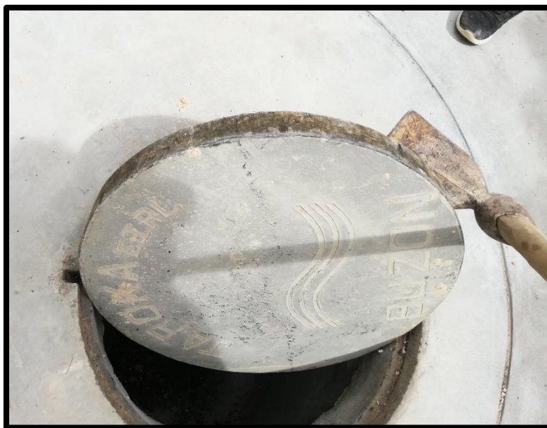
Foto 35: Inspección buzón, Jr. Gonzales Prada
