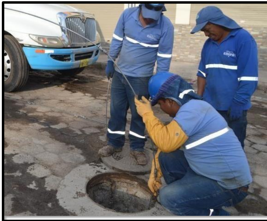
Figura 14. Limpieza manual de las alcantarillas Fuente: EMAPA Ibarra, 2018
