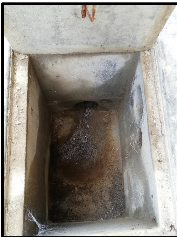
Foto 6: Vista interior de caja de inspección, Jr. Ricardo Palma
