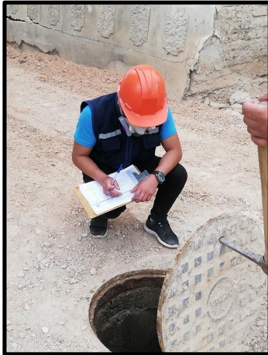
Foto 29: Inspección buzón, Jr. Abelardo Gamarra
