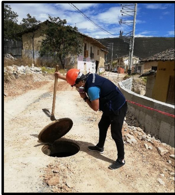
Foto 25: Inspección buzón, Jr. Raymondi
