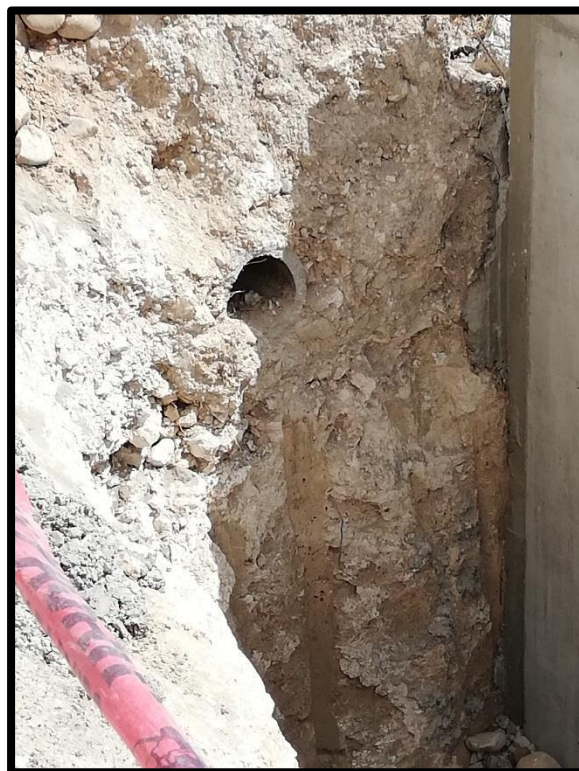
Foto 24: Reemplazo de tubería de concreto, Jr. Raymondi
