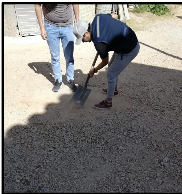
Foto 1: limpieza de tapa de buzón, Jr. El Complejo
