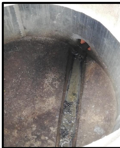
Foto 13: Buzón con media caña buen estado
