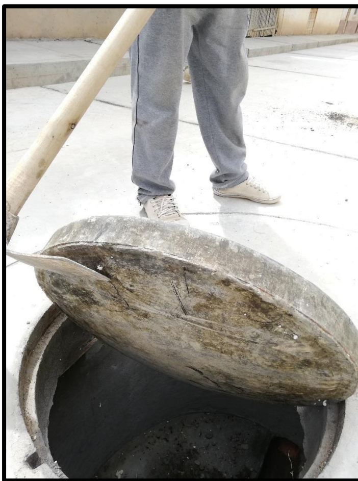
Foto 34: Tapa nueva de concreto, Jr. Gonzales Prada
