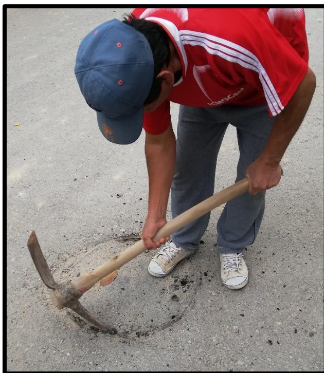
Foto 3: Buzón cubierto con brea, Jr. Ricardo Palma
