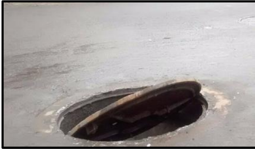
Figura 10. Verificación de tapas de buzones Fuente: RPP NOTICIAS, 2017
