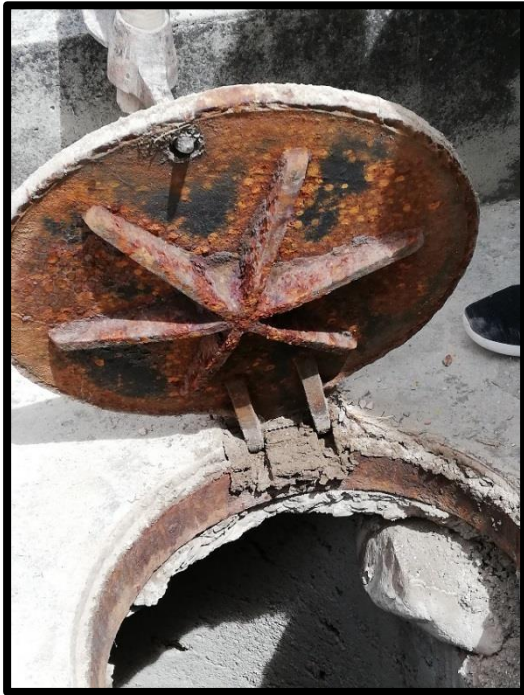
Foto 17: Inspección buzón, Jr. Raymondi
