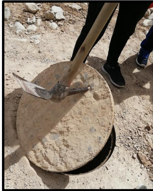
Foto 31: Inspección buzón, Jr. Abelardo Gamarra
