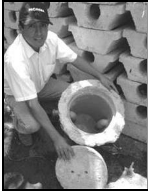
Figura 11. Retiro de la trampa de grasas de cocina para la limpieza Fuente: OPS, 2005
