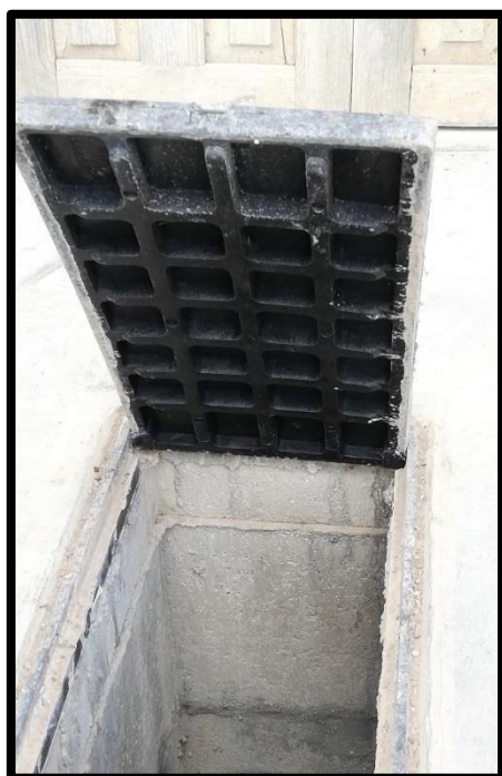
Foto 46: Tapas nuevas cajas de inspección
