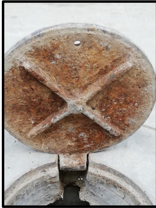
Foto 48: Inspección buzón, Jr. Gonzales Prada
