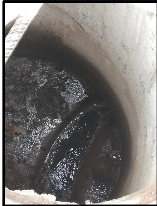
Foto 18: Vista interior buzón, Jr. Raymondi
