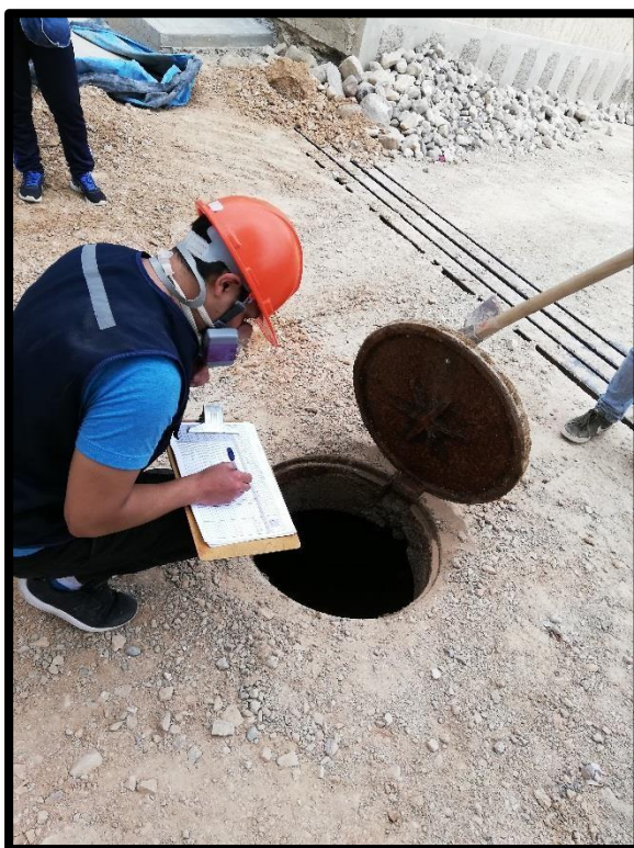
Foto 27: Inspección buzón, Jr. Manco Cápac
