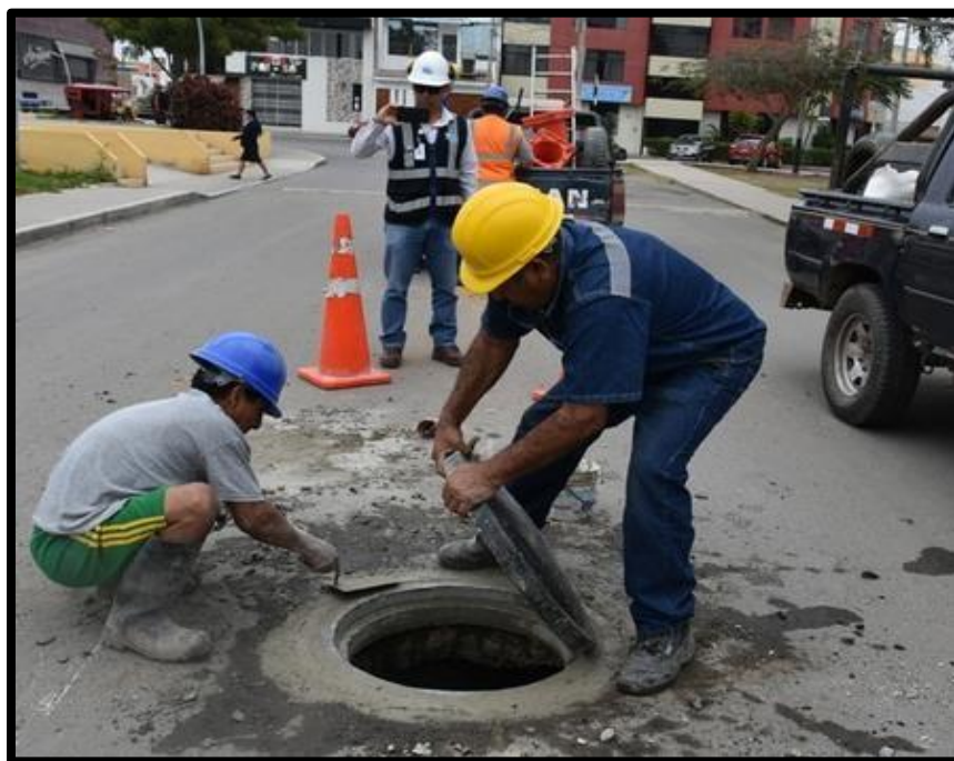
Figura 18. Mantenimiento correctivo de marcos y tapas de buzones Fuente: LA REPÚBLICA, 2019
