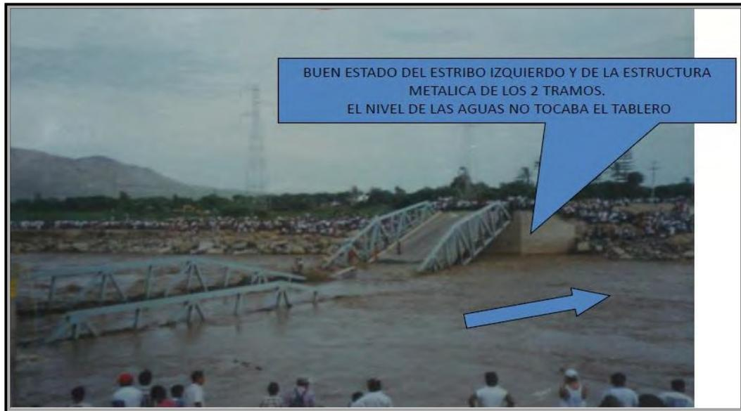
Figura 3. Caída del puente Reque
