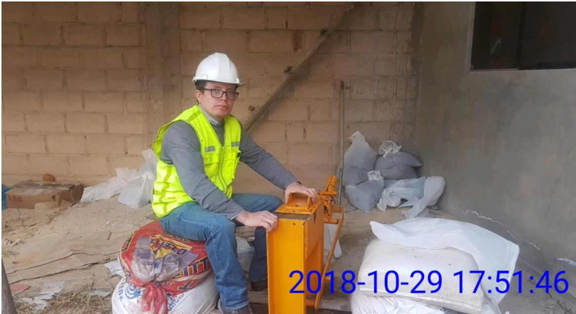
Figura 17. Material listo para ser compactado
