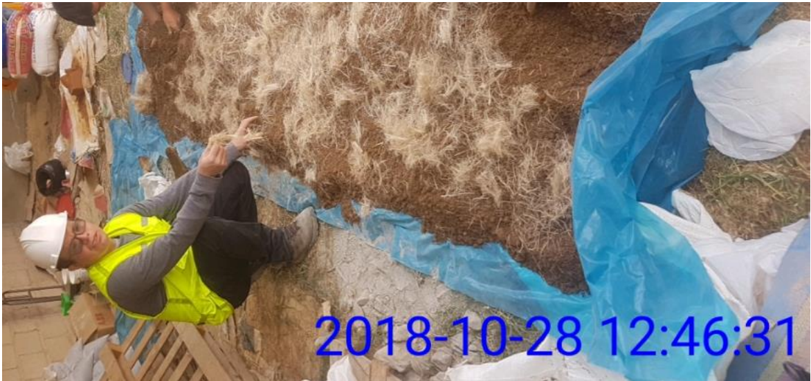
Figura 15. Mezclando el Suelo con la fibra de seudotallo de plátano
