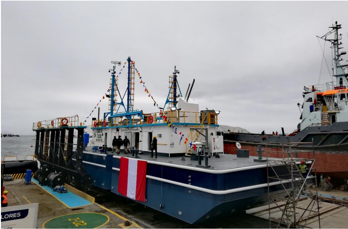
Figura 3. Construcción CHATA TASA (agosto 2019) - Cliente TASA
