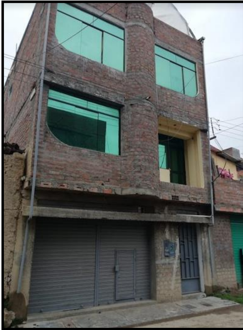
Figura 16 Instalaciones de procesamiento final de APROMAC en Chilca, Huancayo, Junín
