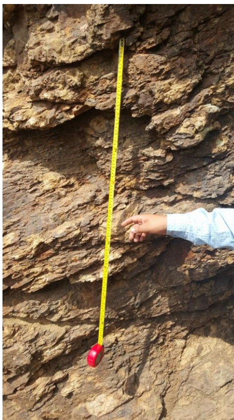
Figura 27 Número de fracturas en Caja Piso Fuente: Elaboración propia.
