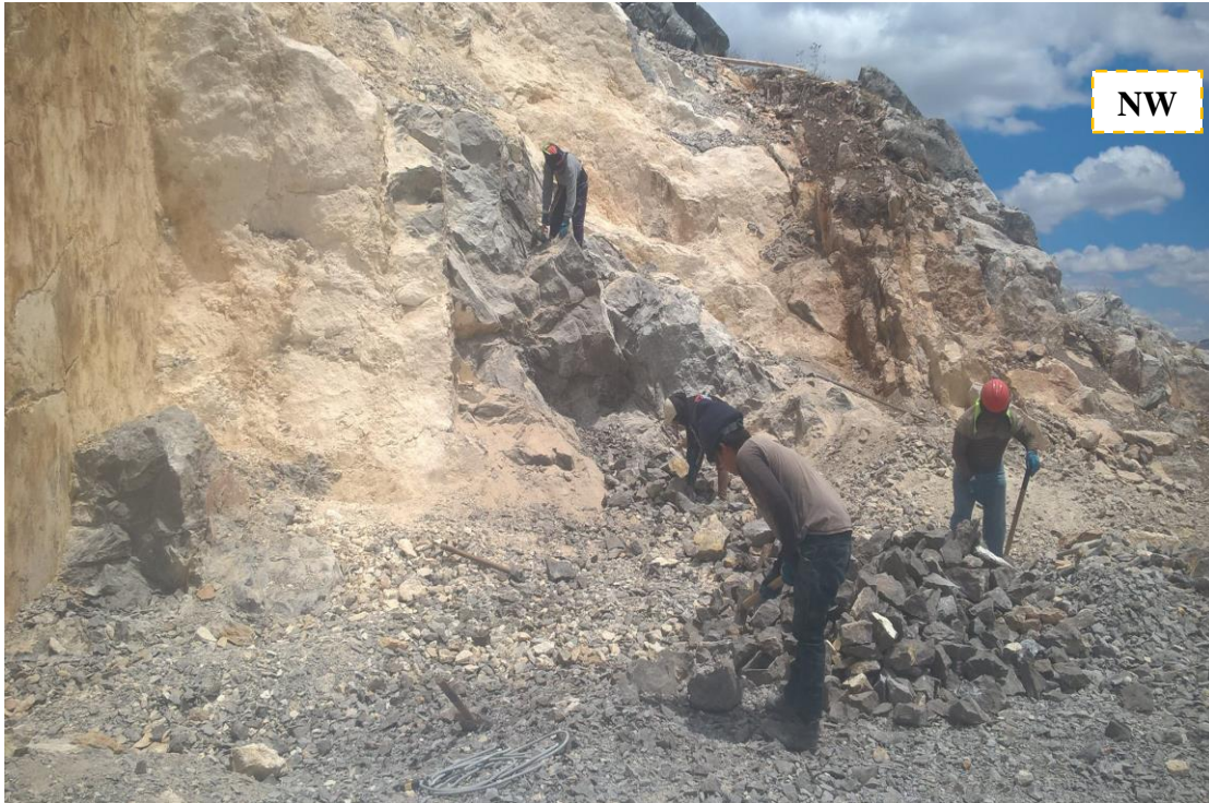
Figura 38. Uso de Herramientas a través del personal para chancar la roca
