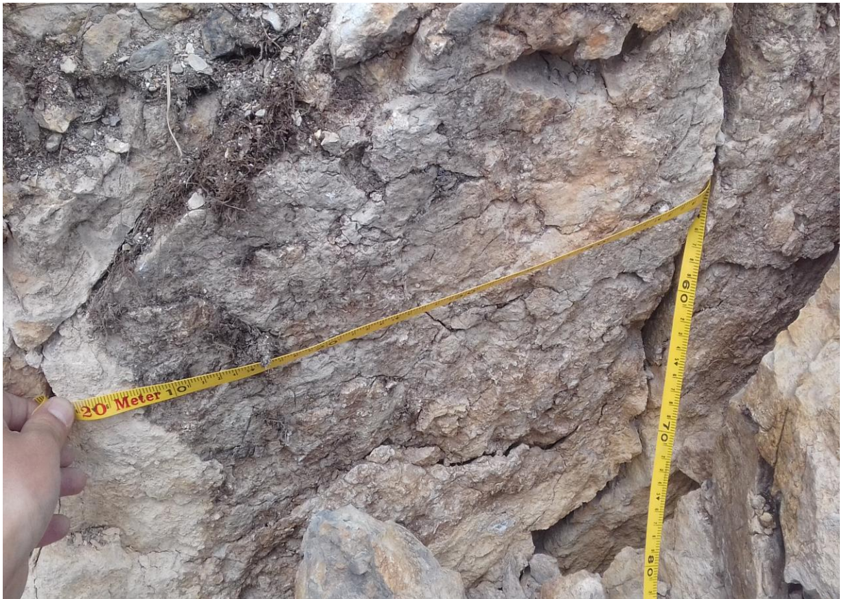
Figura 26. Observando la humedad de la estación 3
