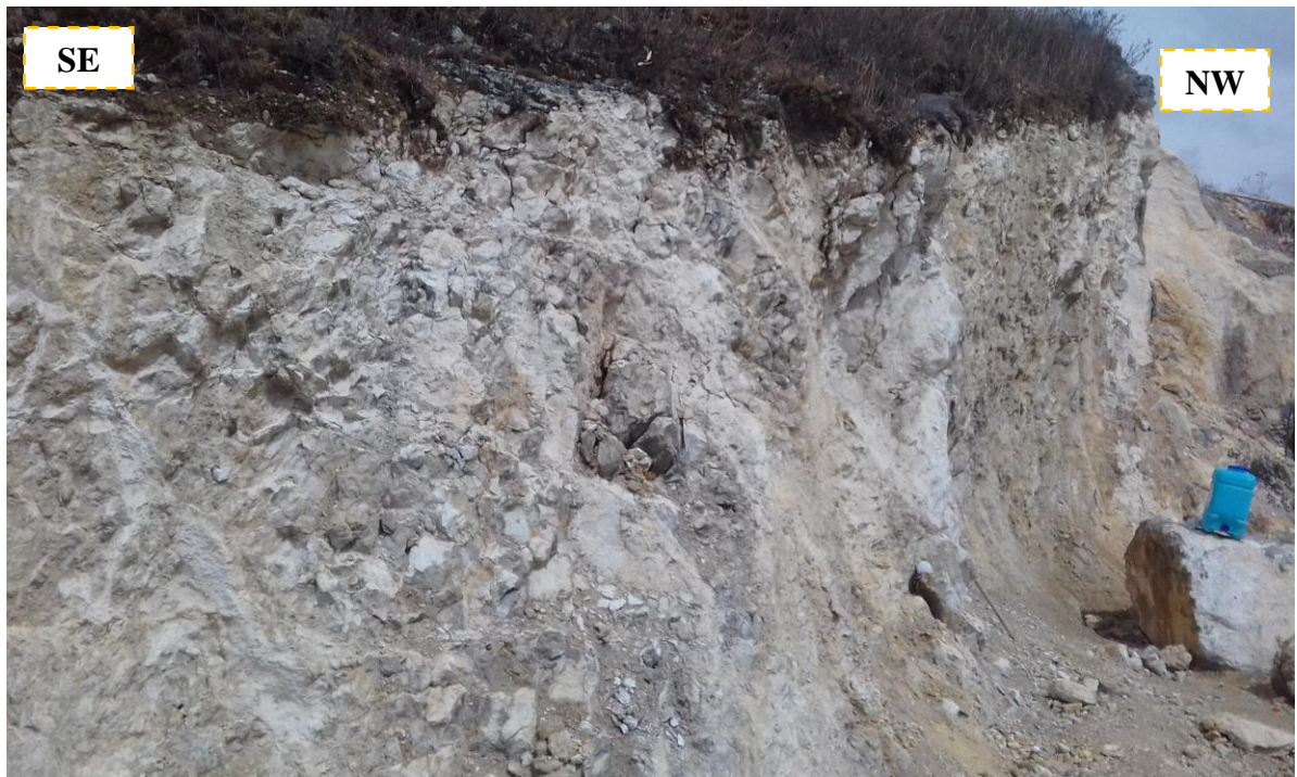
Figura 25. Observando la humedad de la estación 2
