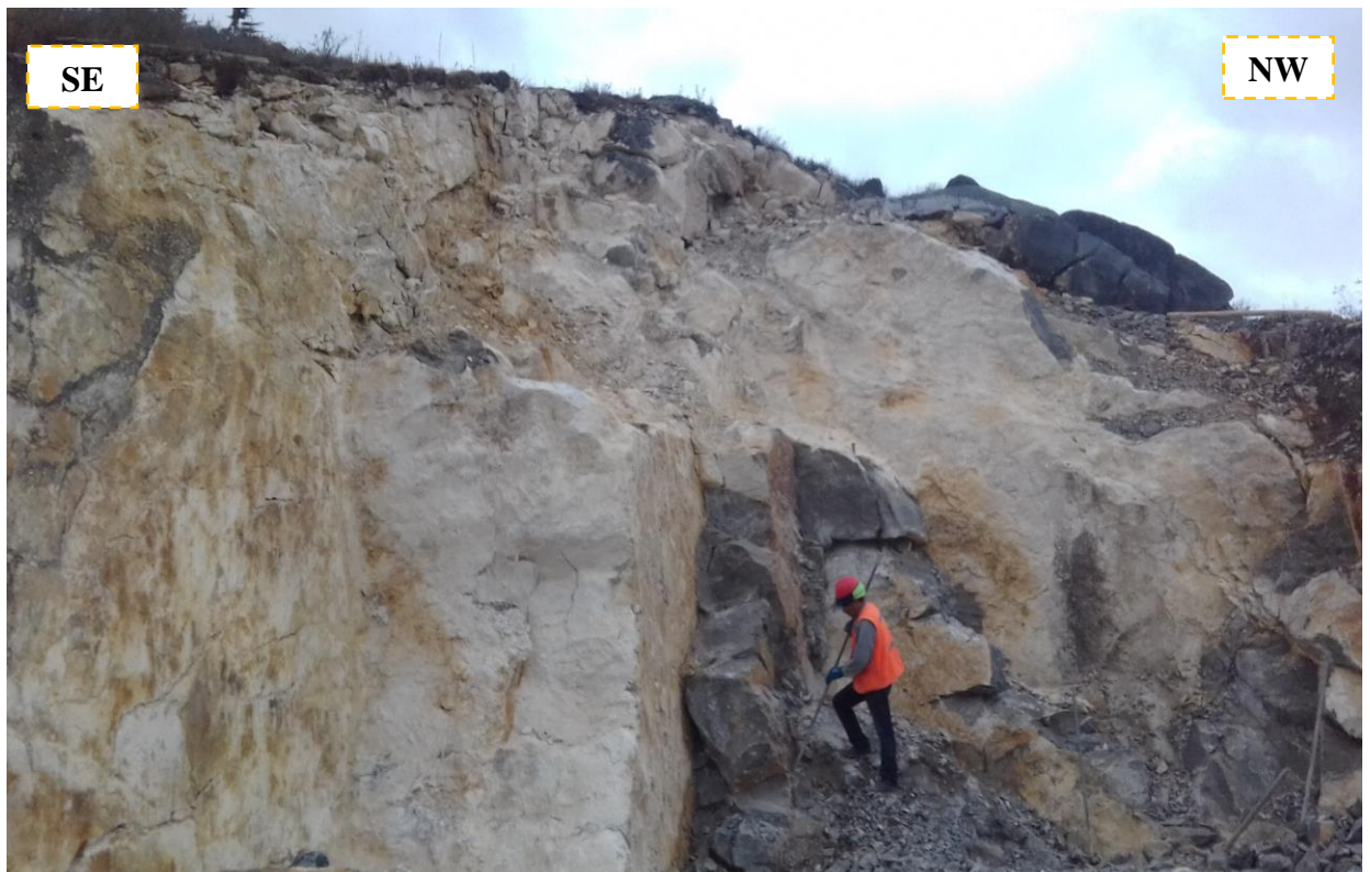
Figura 27. El eje de la excavación es perpendicular a la dirección de los estratos y se encuentra a favor del buzamiento
