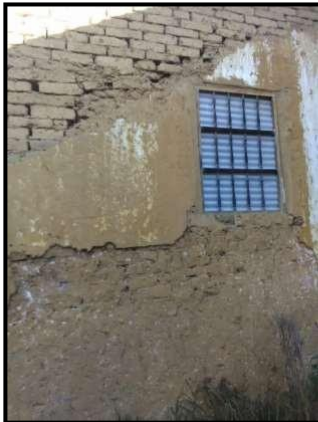
Figura 38: Recubrimiento de pared exterior.
