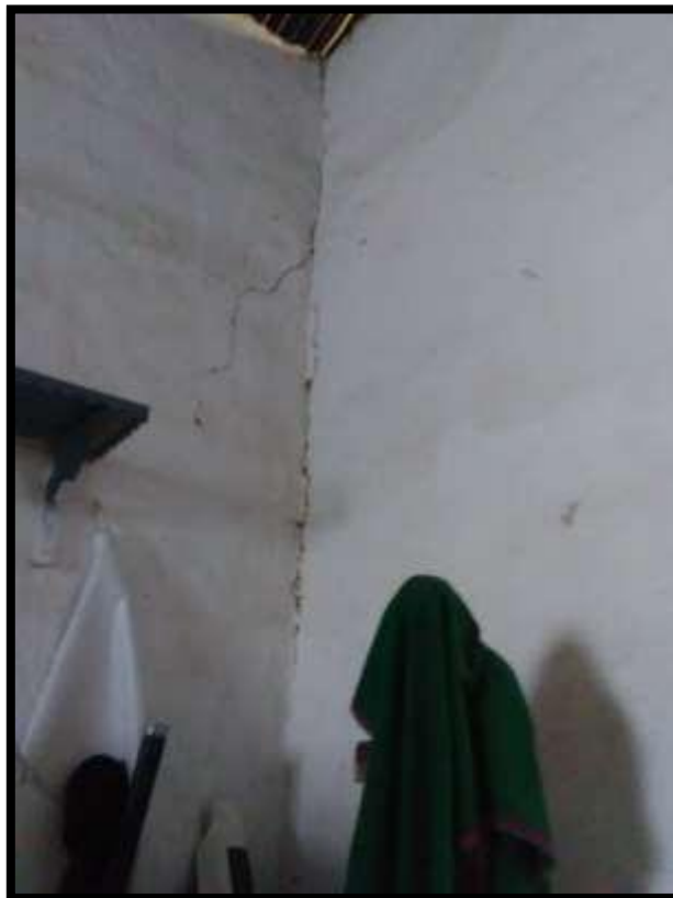
FOTO N° 10: Presencia de fisuras en union de muros
