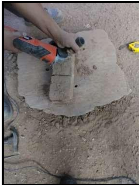
Figura 23: Corte de adobe en cubos.
