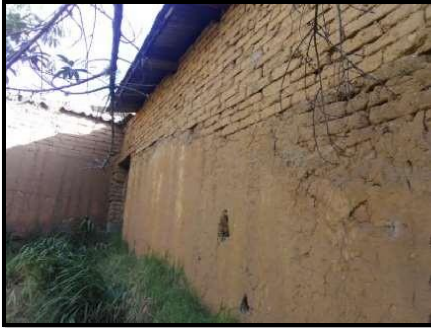
Figura 37: Pared exterior lateral.
