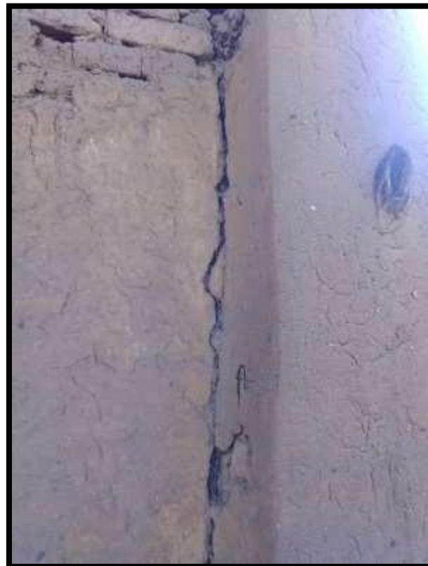
FOTO N° 12: Fisuras en parte exterior de muros
