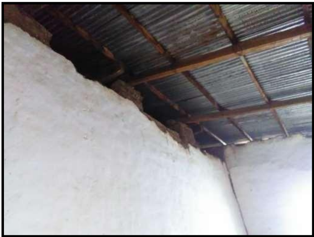
FOTO N° 8: Union muro – techo
