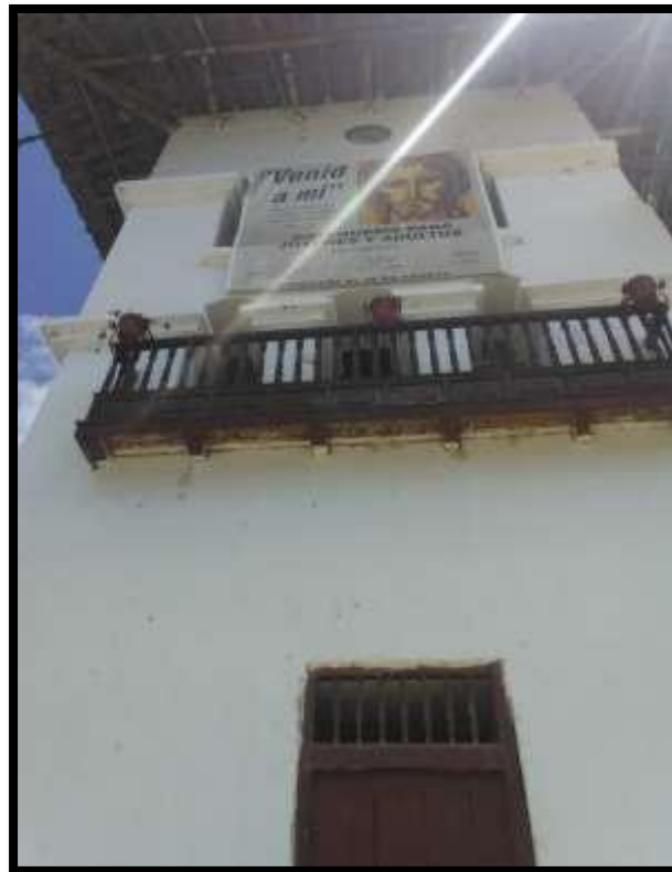
Figura 19: Torre del campanario.
