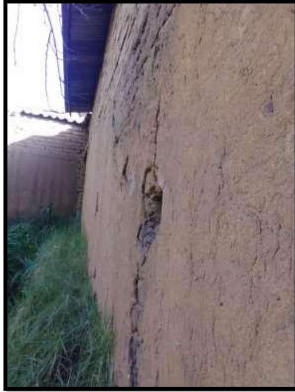
FOTO N° 12: Fisuras en parte exterior de muros
