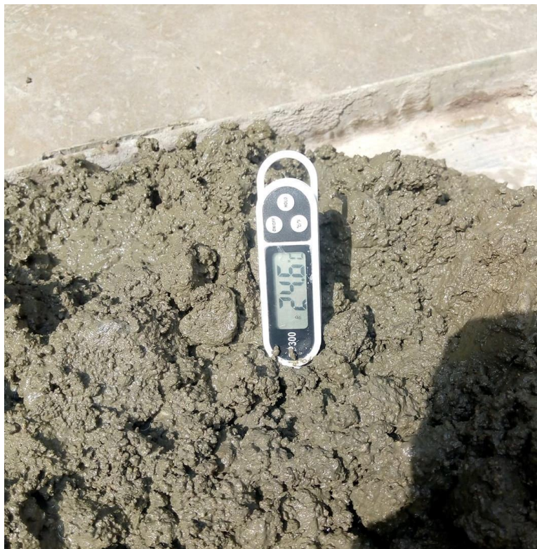
Figura 38. Temperatura del Concreto
