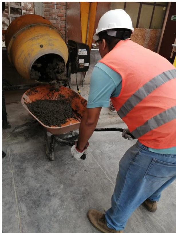
*Figura 21: Recepción del concreto después de 7 minutos de mezclado.*
