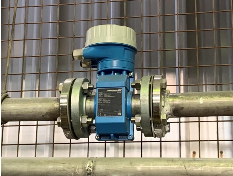
Figura 23: Instalación de flujómetros de dosificación de reactivos
