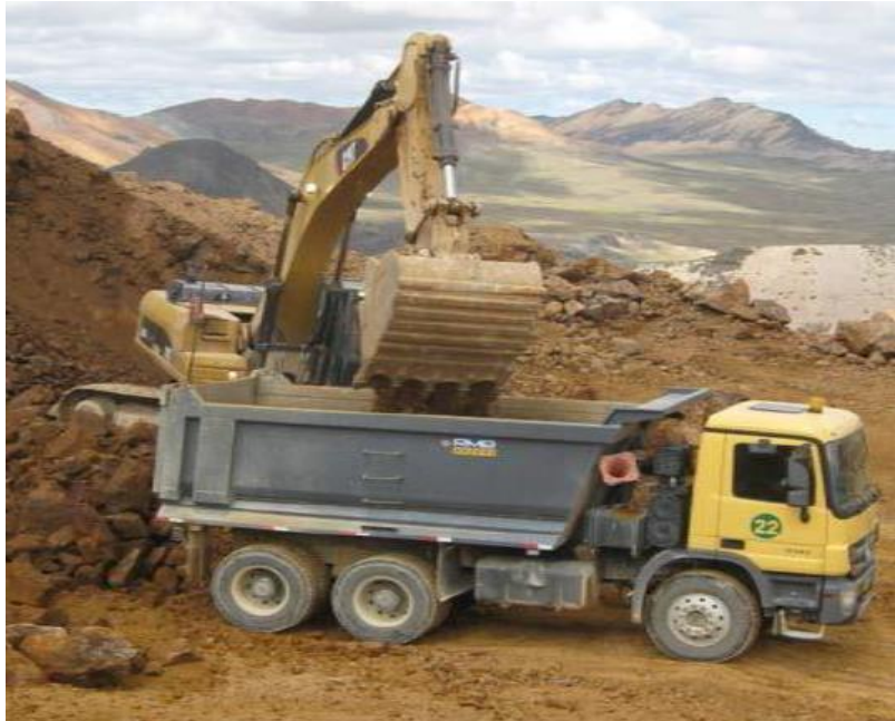
Ilustración 1: Carguío de mineral en el Tajo.
