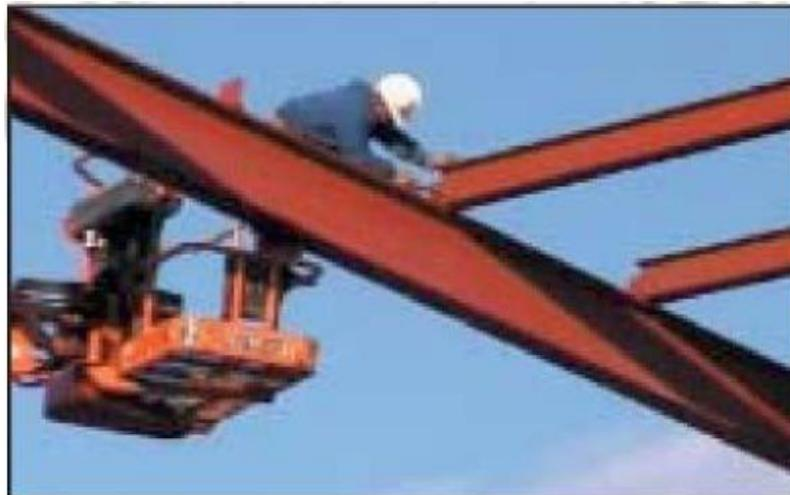
*Figura 13 - Montaje de Estructuras*
