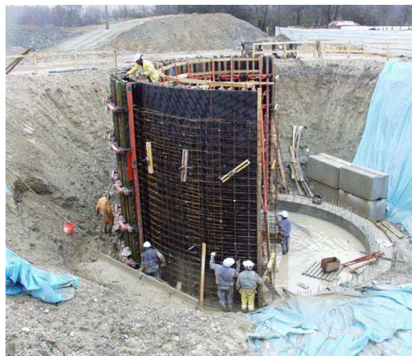
Construcción de embocadura de un pozo.
