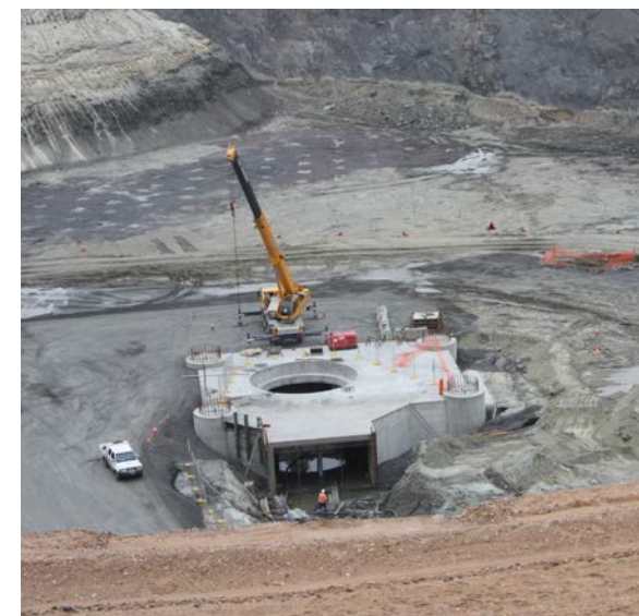
Construcción de pozo para el proyecto Chuquicamata Subterráneo (Chile).
