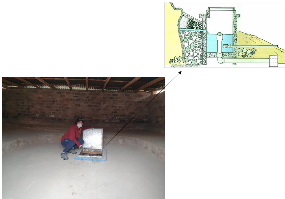
Figura. 60. Cámara húmeda de captación. Fuente: Propia.
