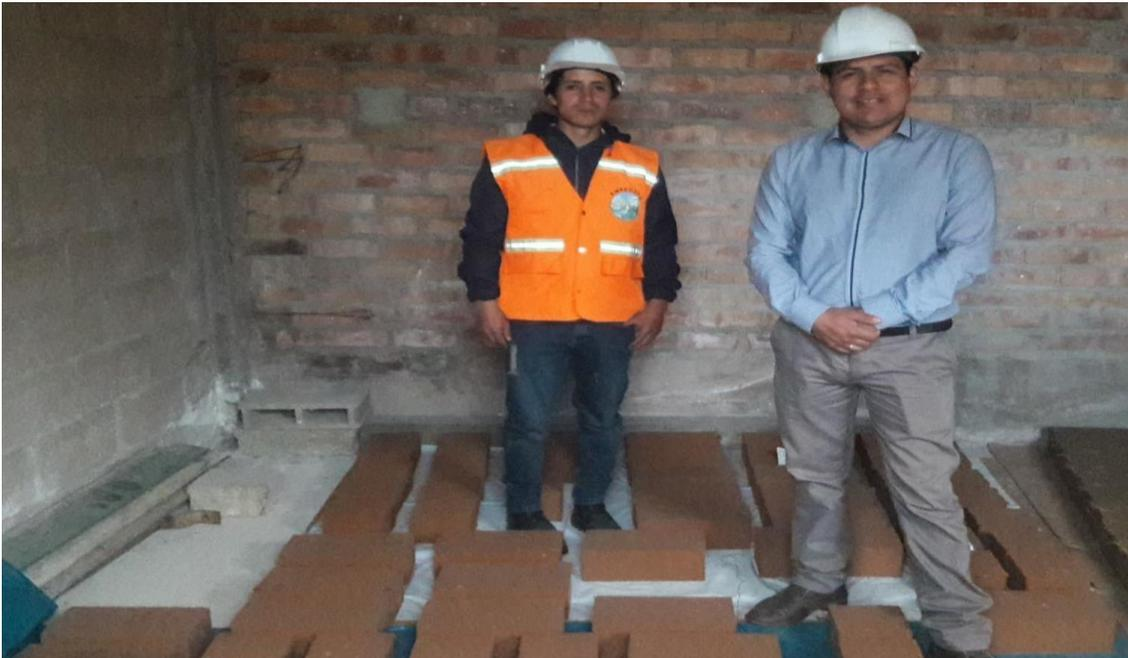
*Fotografía 20. Curado de los Bloques de Tierra Comprimida*
