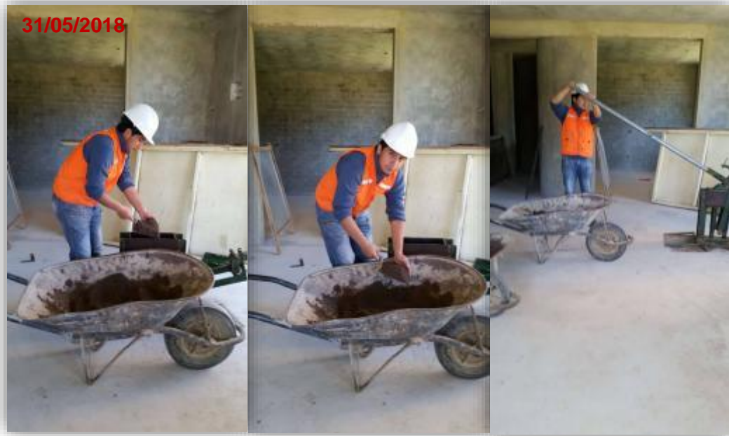
Fotografía 15 - Elaboración de los adobes en la CINVA RAM.
