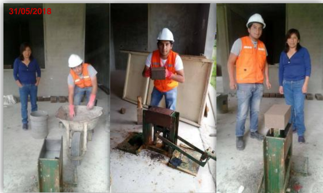
Fotografía 16 - Elaboración de los adobes bajo la supervisión de la ingeniera de Suelos.
