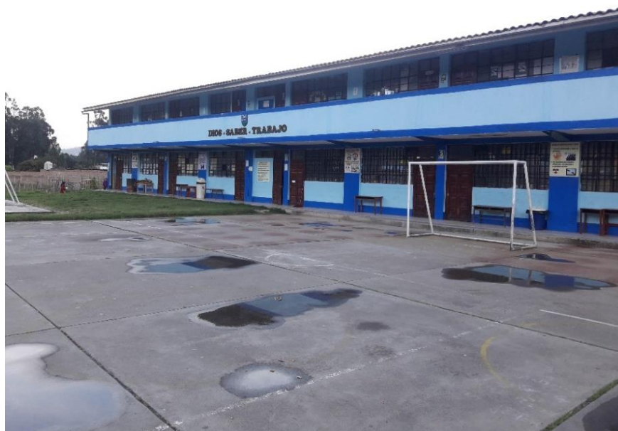
Figura 105 Vista de puertas, ventanas, cobertura de techo, aulas
