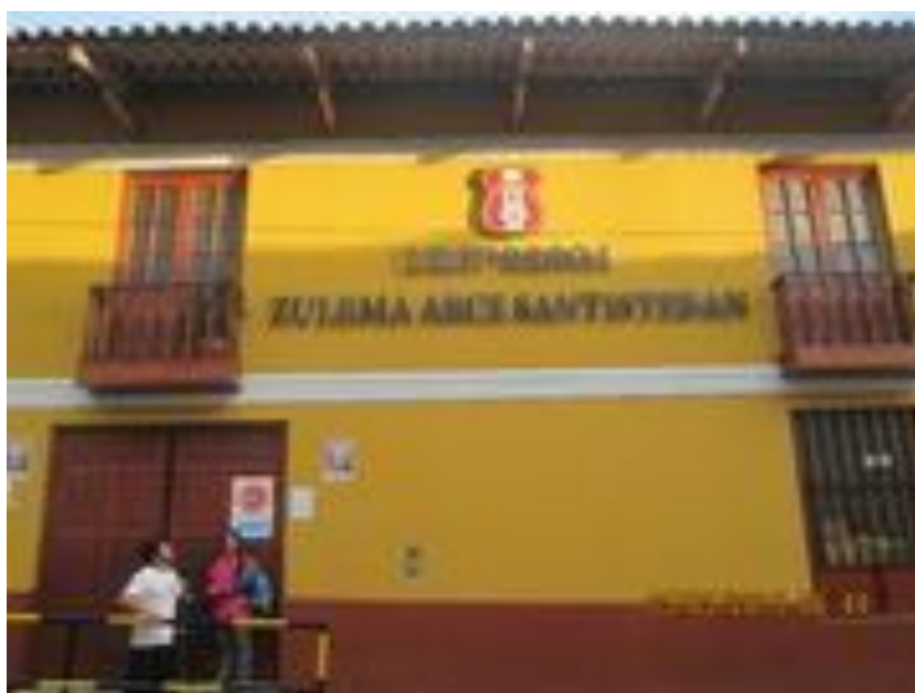
Figura 115 Vista de muros exteriores de la institución educativa
