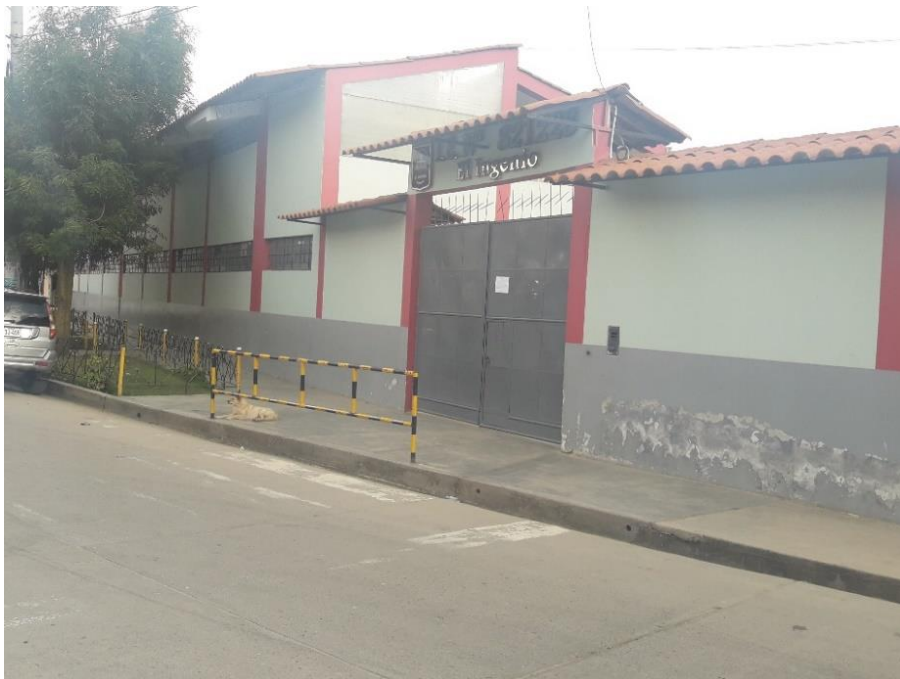
Figura 83. Vista de muros exteriores, cobertura de techo
