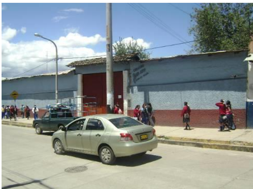
Figura 87. Vista de muros exteriores, cobertura de techo
