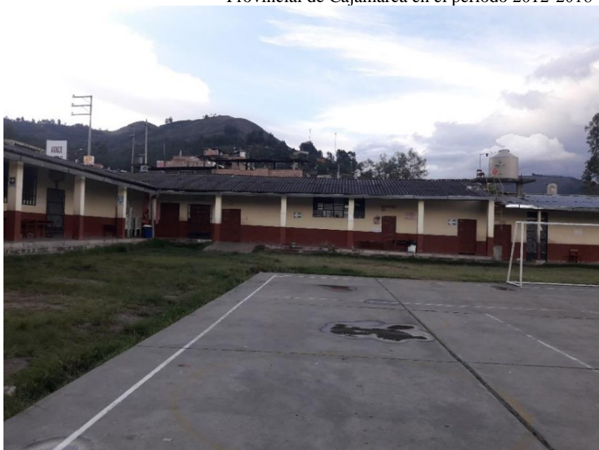
Figura 104. Vista de plataforma, muros de aulas, cobertura de techo
