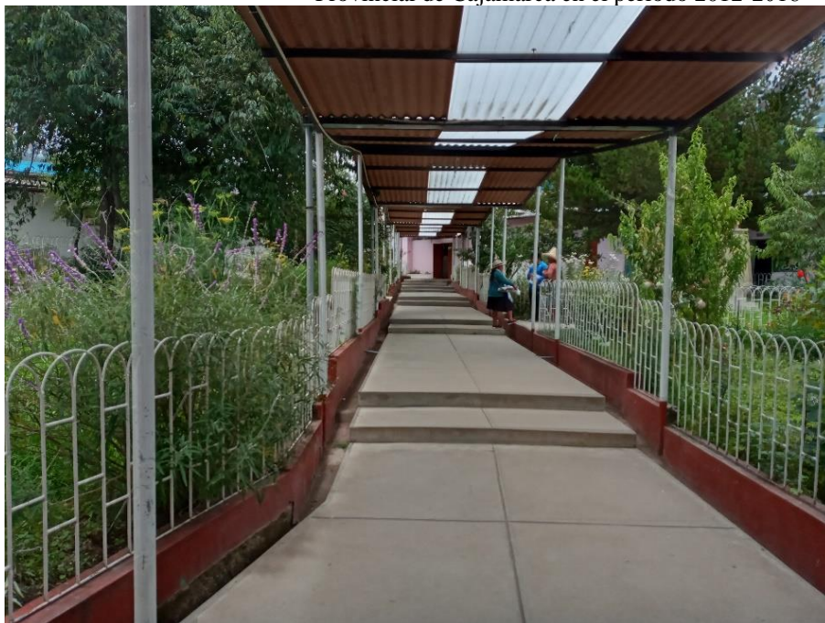
Figura 89. Vista de pasadizo de concreto
