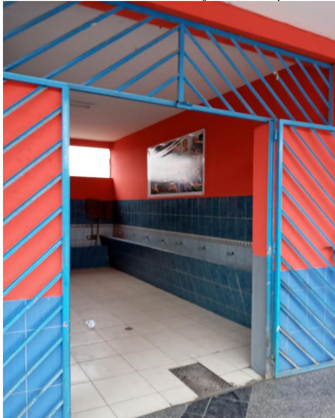
Figura 95. Vista de elementos sanitarios
