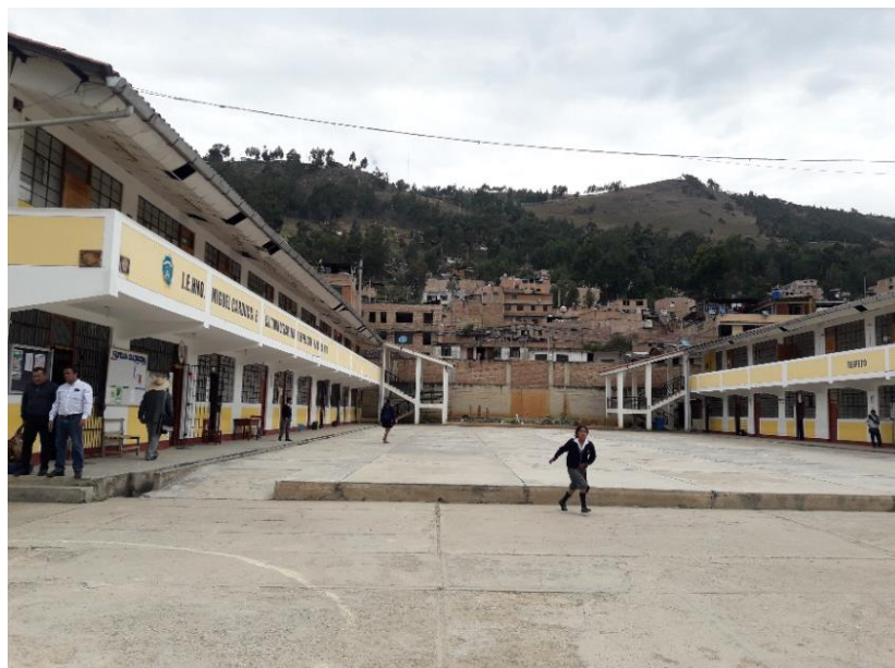
Figura 74. Vista de espacio externo
