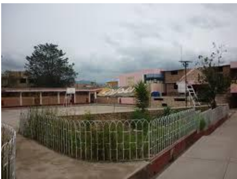
Figura 88. Vista de plataforma, veredas, jardineras
