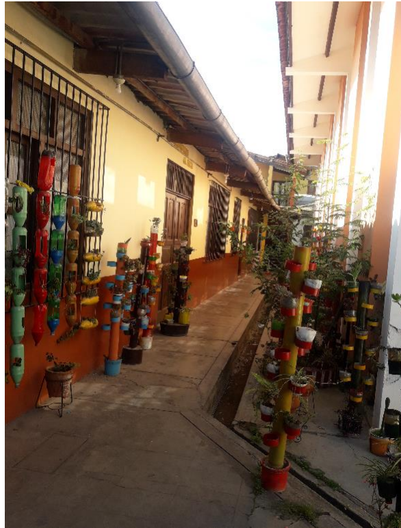
Figura 81. Vista de coberturas de techos, canaleta de concreto en piso
