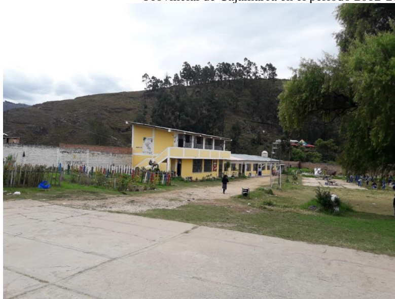
Figura 75. Vista de espacio externo
