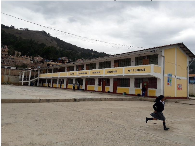
Figura 77. Vista de cobertura de techo
