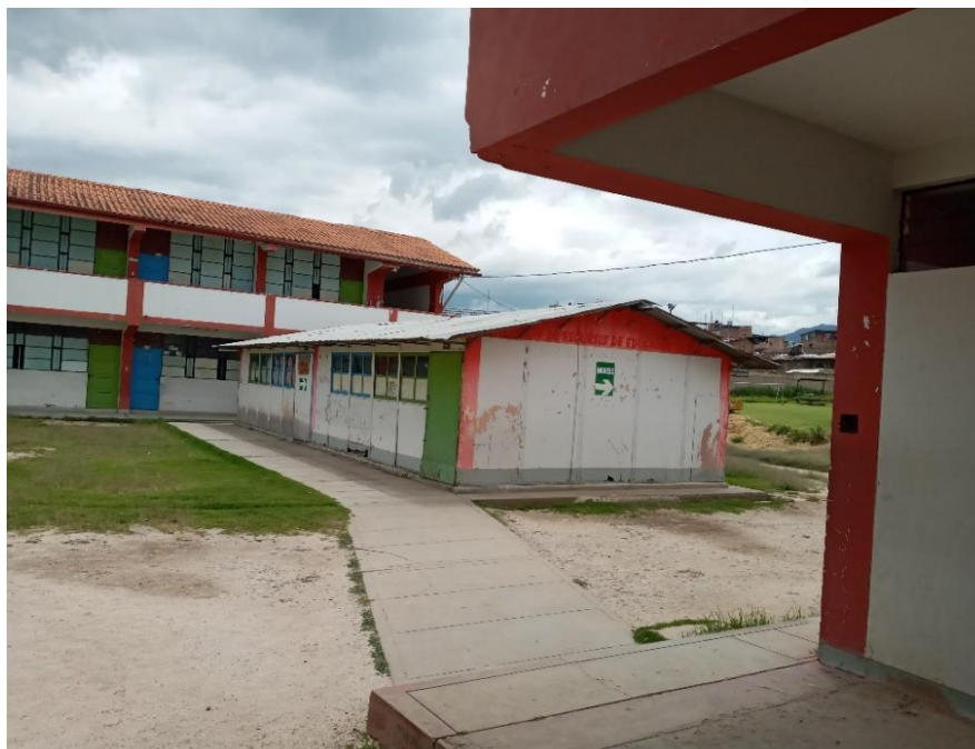
Figura 90. Vista de puertas, ventanas, veredas, cobertura de techo
