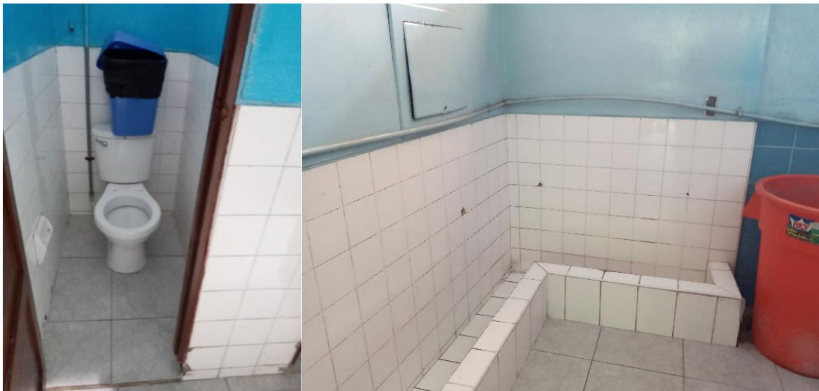
Figura 82. Vista de inodoros, urinario, zócalo de cerámico
