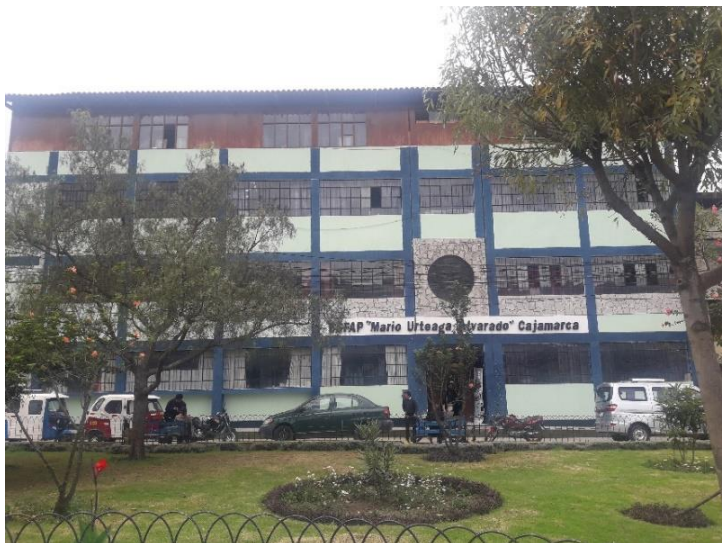
Figura 96. Vista de muros exteriores, ventanas
