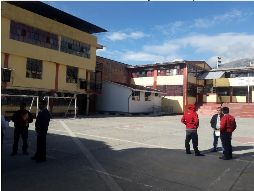
Figura 79. Vista de plataforma, gradas de concreto.
