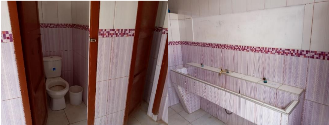
Figura 91. Vista de elementos sanitarios
