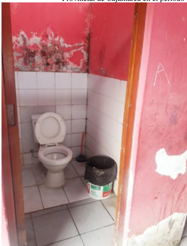
Figura 106. Vista de elementos sanitarios
