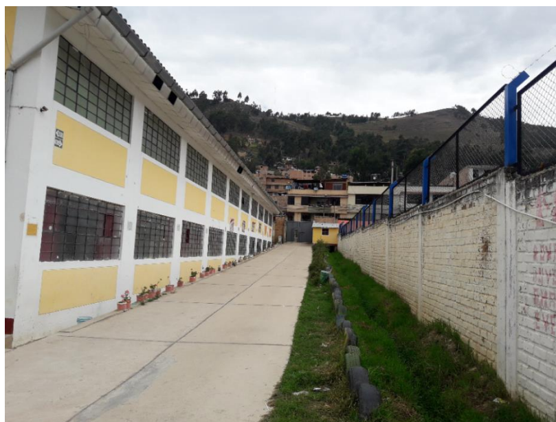
Figura 76. Vista de cerco perimétrico
