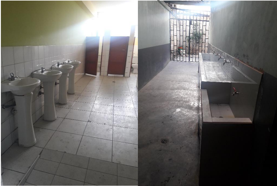
Figura 85. Vista de aparatos sanitarios
