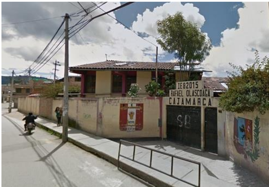
Figura 108. Vista de cerco perimétrico, cobertura de techo
