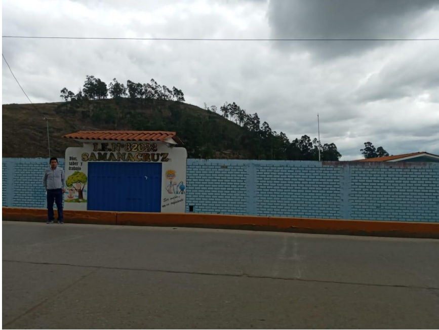
Figura 102. Vista de cerco perimétrico de la institución educativa
