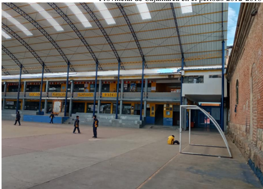
Figura 93. Vista de muros, cobertura de techo de plataforma
