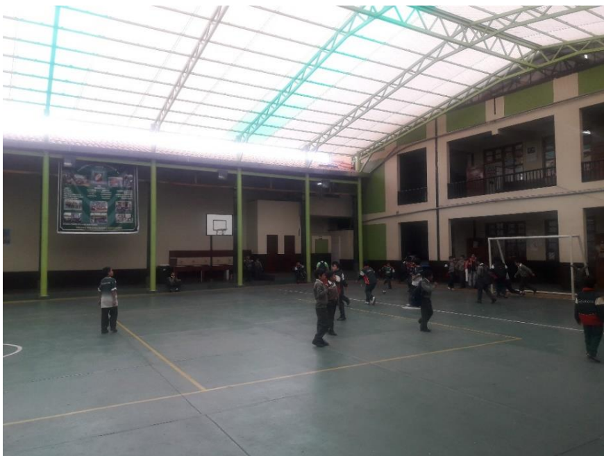
Figura 119. Vista de cobertura de techo de plataforma, muros
