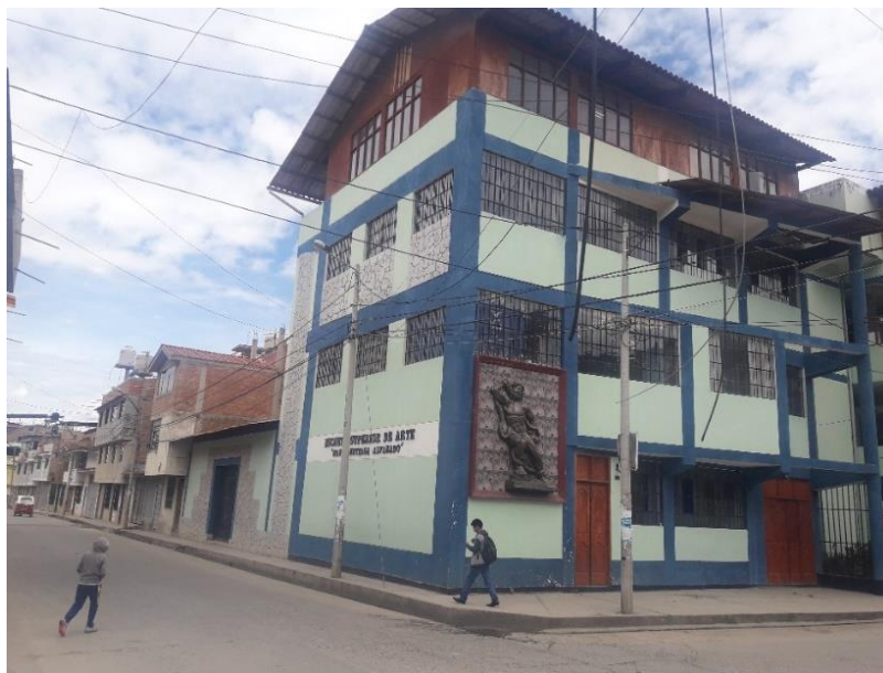
Figura 97. Vista de muros, ventanas, puertas, cobertura de techo
