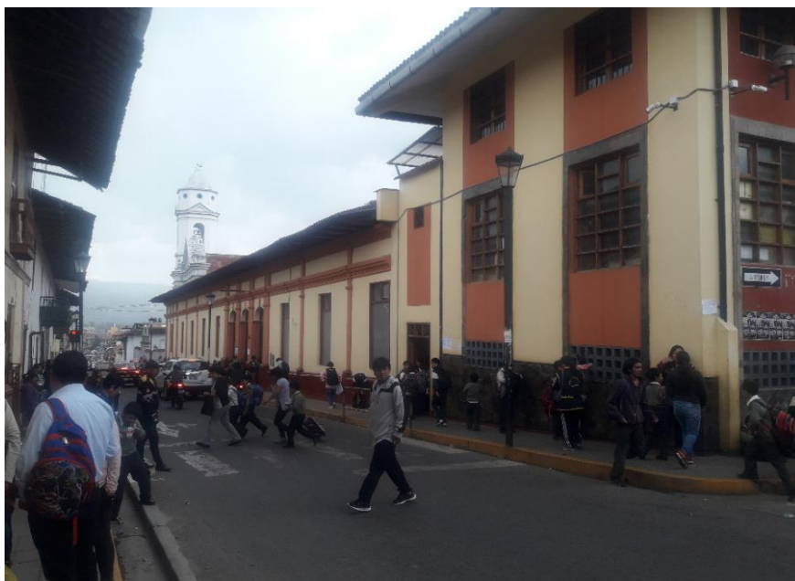
Figura 118. Vista de muros exteriores de la institución educativa
