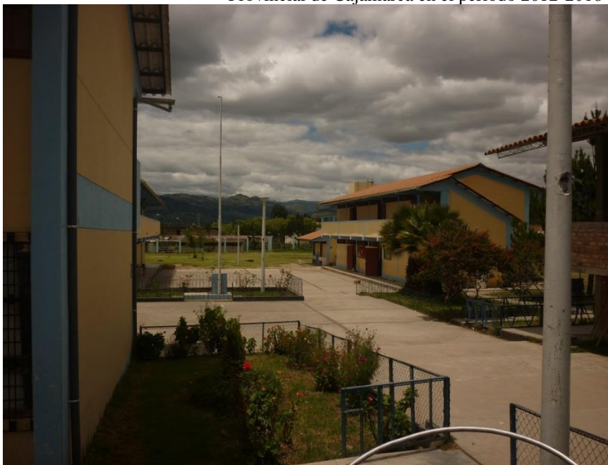
Figura 112. Vista de muros, jardineras
