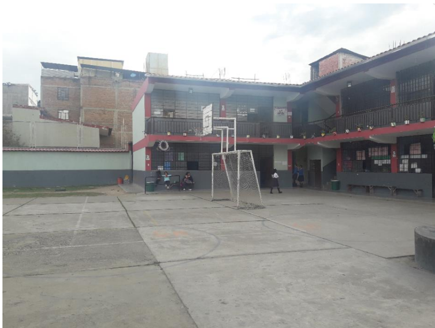
Figura 84. Vista de plataforma, aulas, muros exteriores, ventanas, puertas
