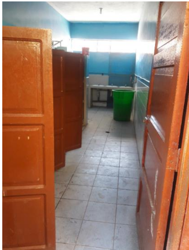
Figura 80. Vista de elementos de los servicios higienicos
