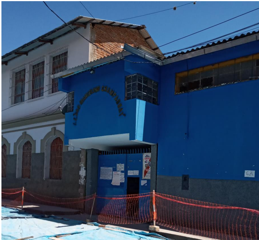
Figura 92. Vista de muros exteriores de la institución educativa
