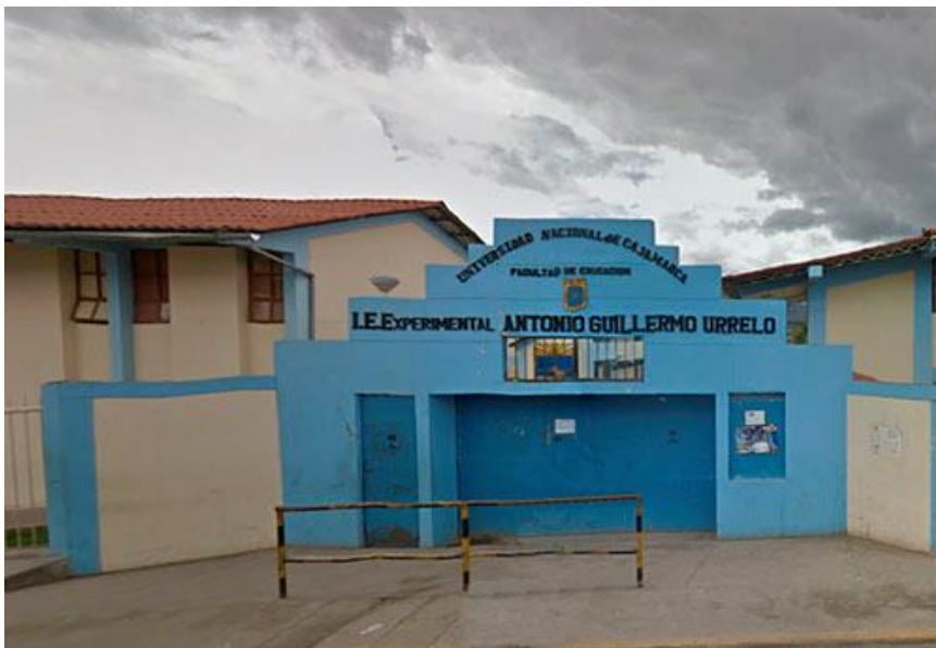
Figura 111. Vista de cerco perimétrico, muros, cobertura de techo
