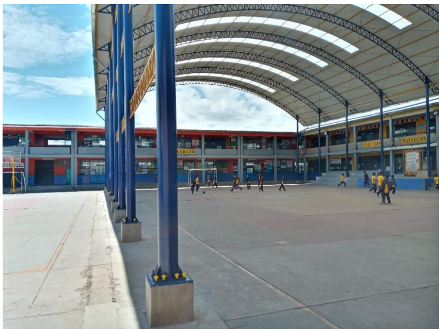
Figura 94. Vista de plataforma, ventanas, puertas
