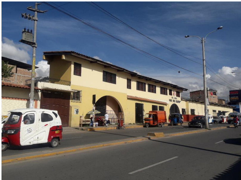
Figura 78. Vista de muros exteriores de la institución educativa
