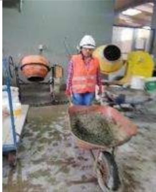
*Foto19:* Traslado de la mezcla hacia el área vaciado.
