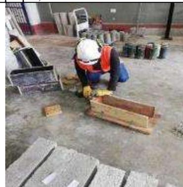
*Foto 36:* Se desencofro las vigas y probetas, así volviendo a armar los moldes para su uso en los siguientes diseños.
