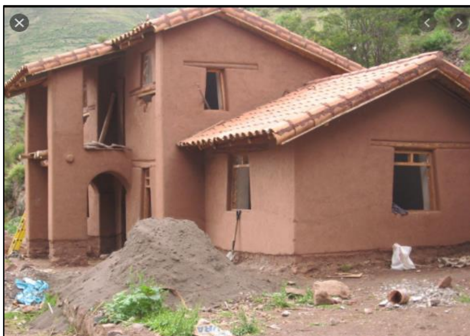
Figura 16. Sistema constructivo Adobe.
