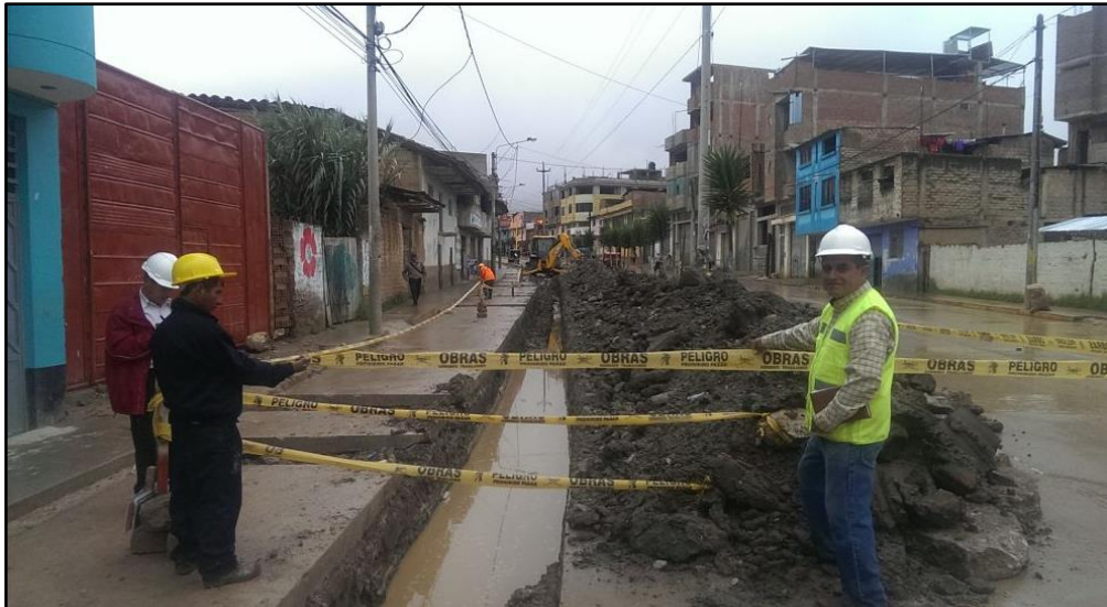
Figura 1 Canalización de Tuberías.
