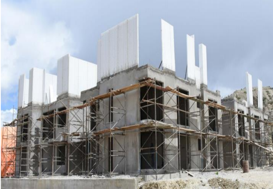
Figura 30. Poliestireno en Edificaciones.
