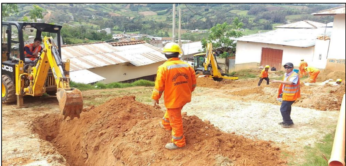
Figura 2 Excavación y Movimiento de tierra.
