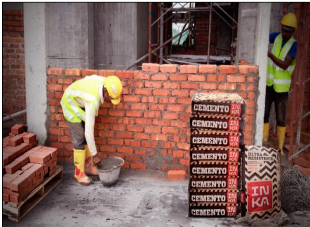
Figura 24. Muro no Portante.
