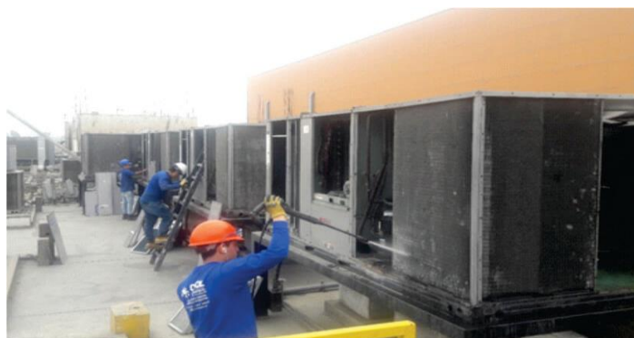
Figura 3.12 Labores de mantenimiento
