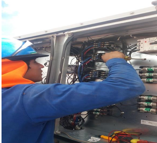
Figura 3.35 Labores de mantenimiento (I)
