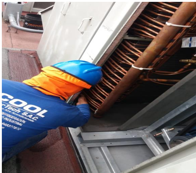
Figura 3.36 Labores de mantenimiento (II)
