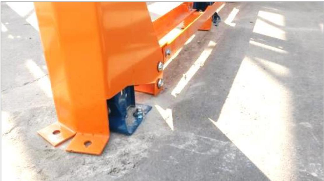
*Figura 25 - Colocación de Placas Metálicas y Anclaje de la Estructura - 2*
