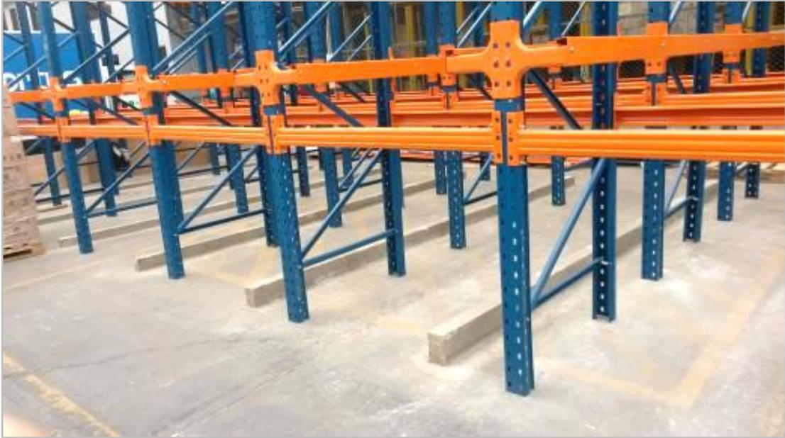
*Figura 21 - Bases de Concreto para la Estructura - 2*
