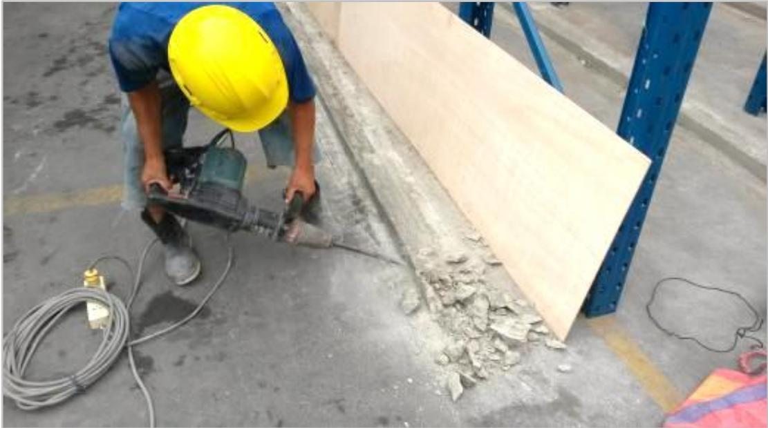
*Figura 22 - Destrucción de las Bases de Concreto*
