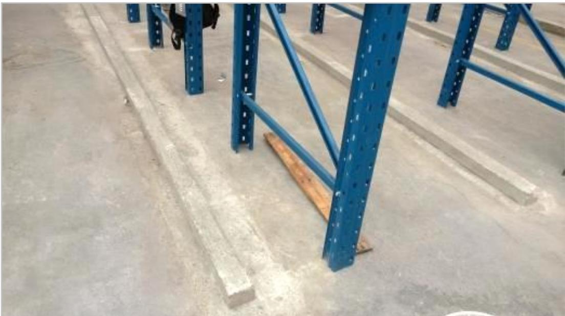
*Figura 20 - Bases de Concreto para la Estructura - 1*
