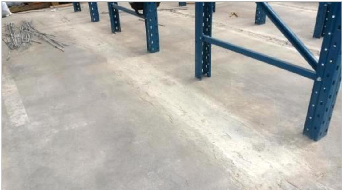
*Figura 23 - Resane y Nivelado del Pavimento*
