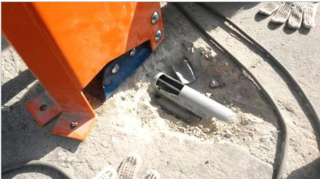
*Figura 26 - Perforación del Pavimento para Anclaje de la Estructura*
