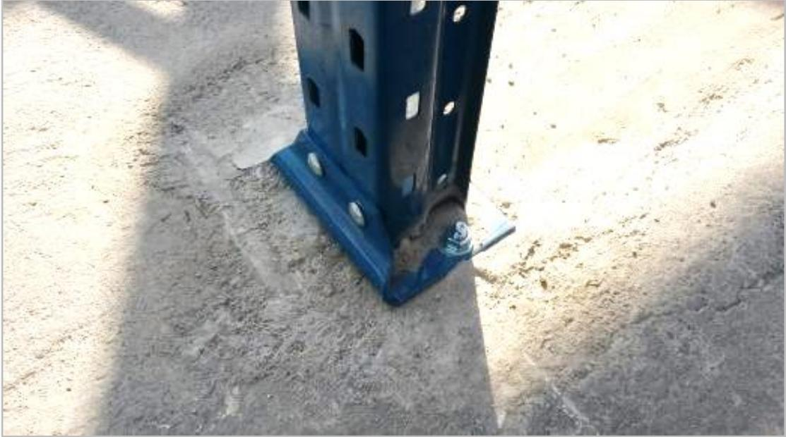
*Figura 24 - Colocación de Placas Metálicas y Anclaje de la Estructura - 1*
